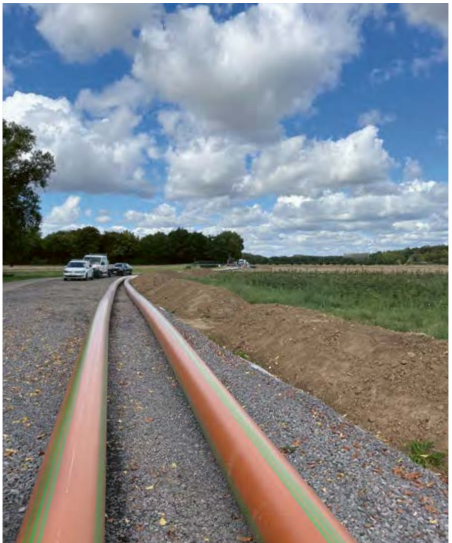
Leitungsverlegung von Miel nach Flerzheim
