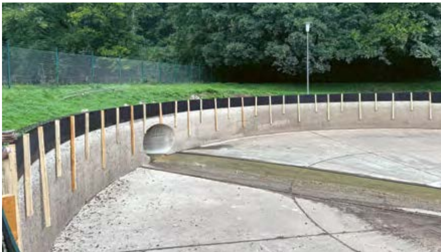
RÜB Mechernich: Abtrag und Neuaufbau des Betons an der Beckenkronen
