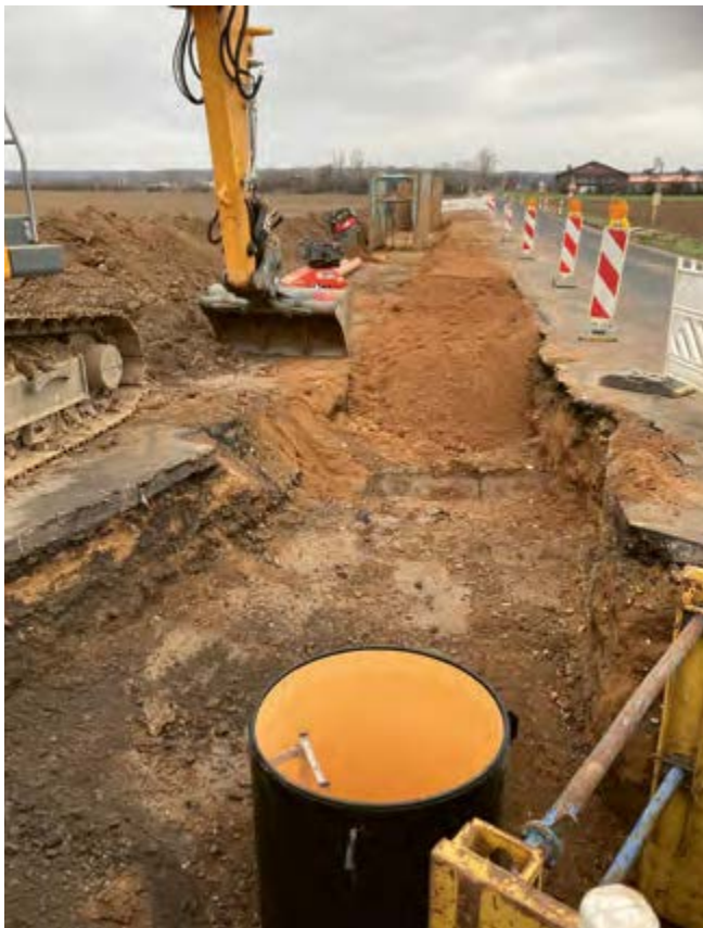
Kanalbau in der Rheindorfer Straße in Muggenhausen
