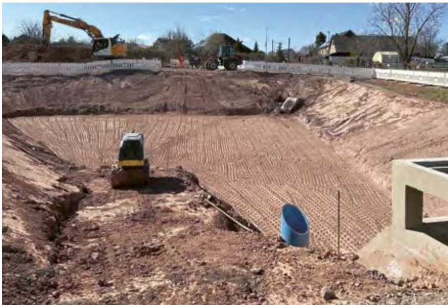
Errichtung des RRB Weiler am Berge, Mechernich
