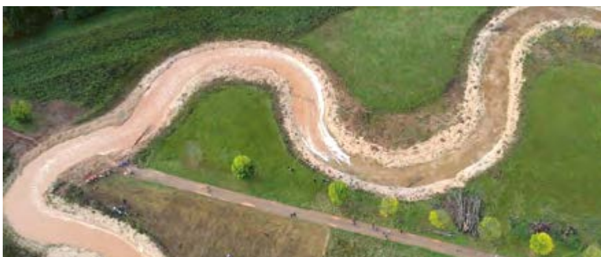
Luftaufnahme der fortschreitenden Abflusswelle nach dem Umschluss
