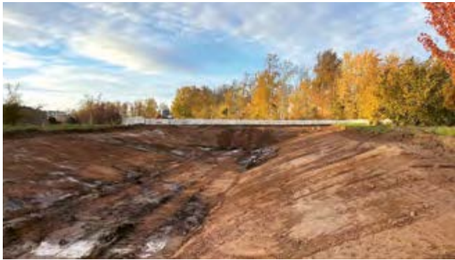
Aushub des Gerinnes (Stand November 2025)
