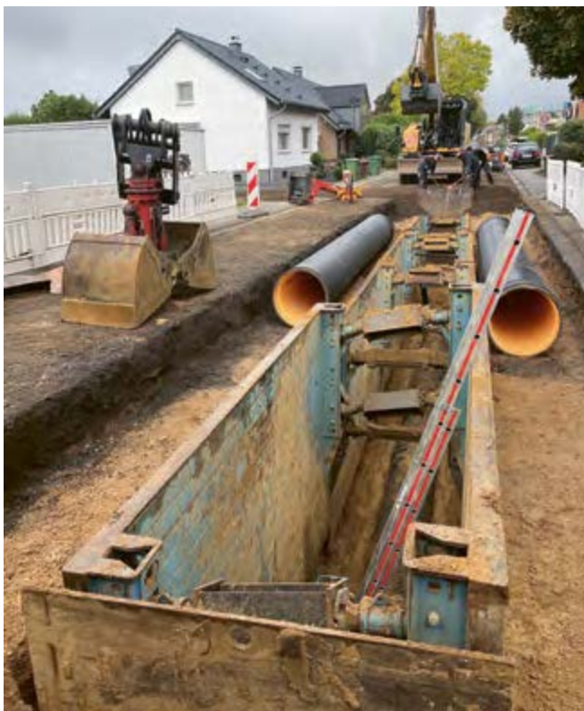
Baugrubenverbau der offenen Kanalsanierung in Alt-Meckenheim
