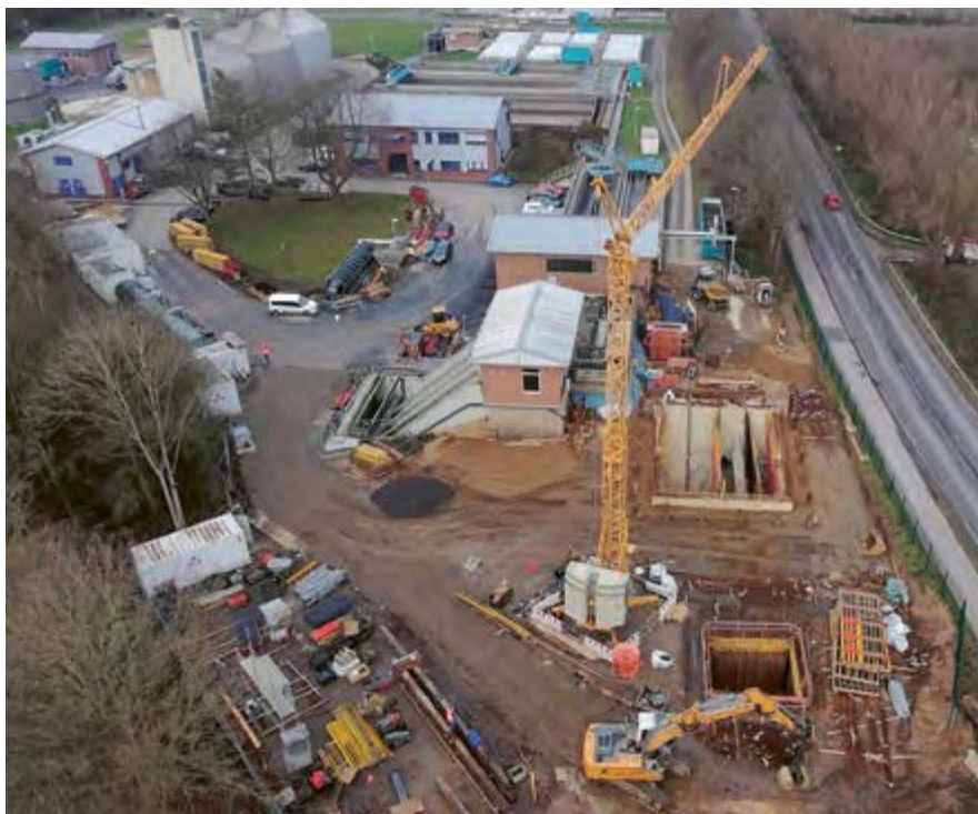
Bau des neuen Zulaufpumpwerkes auf dem GKW Bergheim-Kenten
