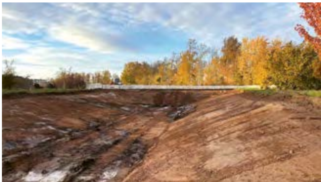
Aushub des Gerinnes (Stand November 2025)
