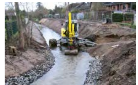
Schreitbagger im Einsatz bei den Sanierungsarbeiten an der Ufermauer in Wevelinghoven
