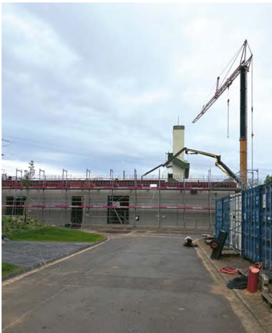
Neubau des Technikgebäudes auf der KA Köttingen
