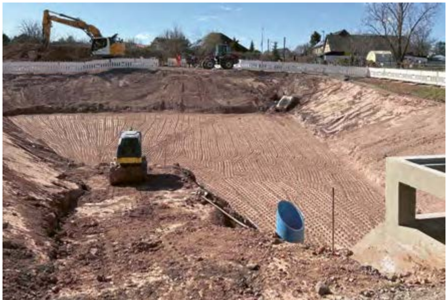
Errichtung des RRB Weiler am Berge, Mechernich
