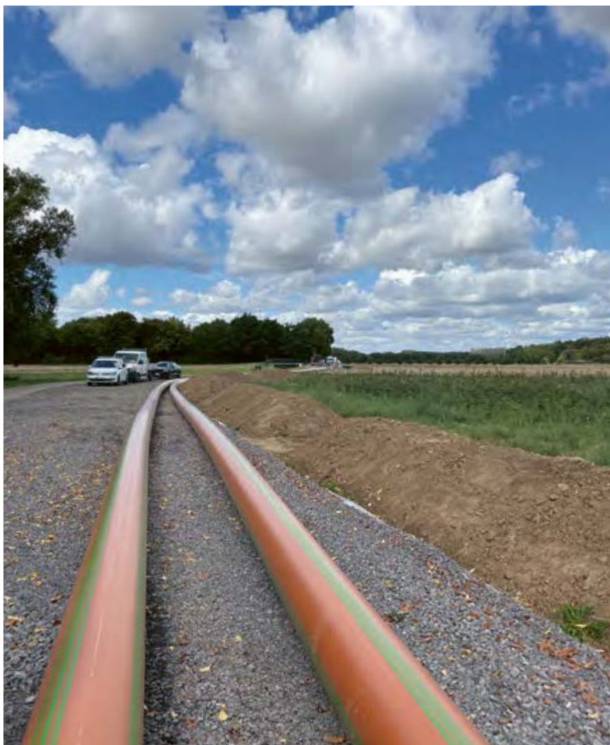
Leitungsverlegung von Miel nach Flerzheim
