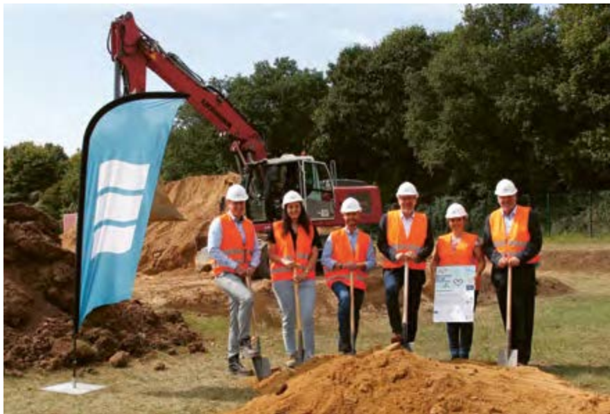
Spatenstich Deammonifikation GKW Bergheim-Kenten
