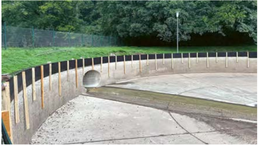
RÜB Mechernich: Abtrag und Neuaufbau des Betons an der Beckenkronne
