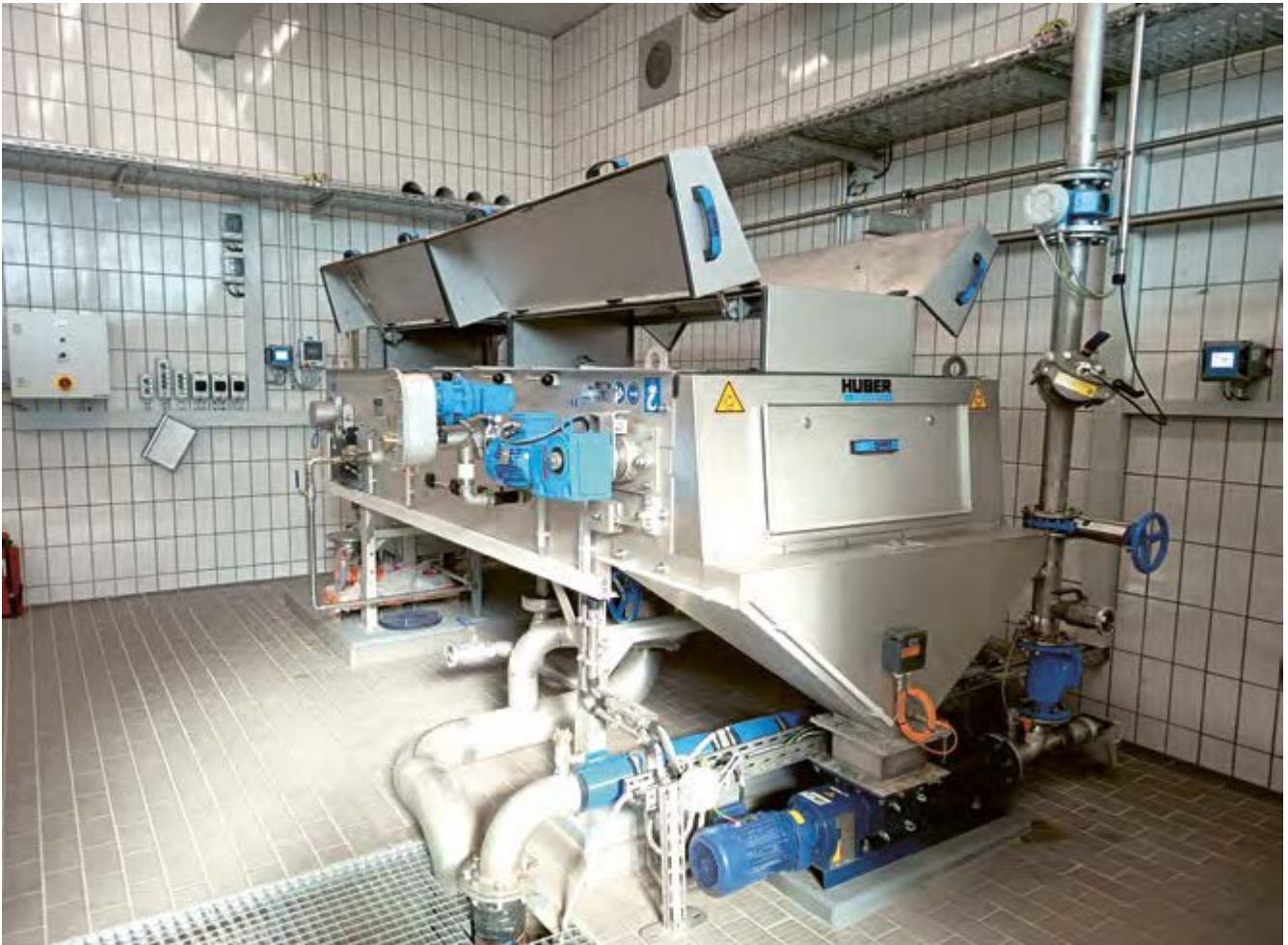
Installation der neuen maschinellen Schlammverdickung auf dem GWK Grevenbroich
