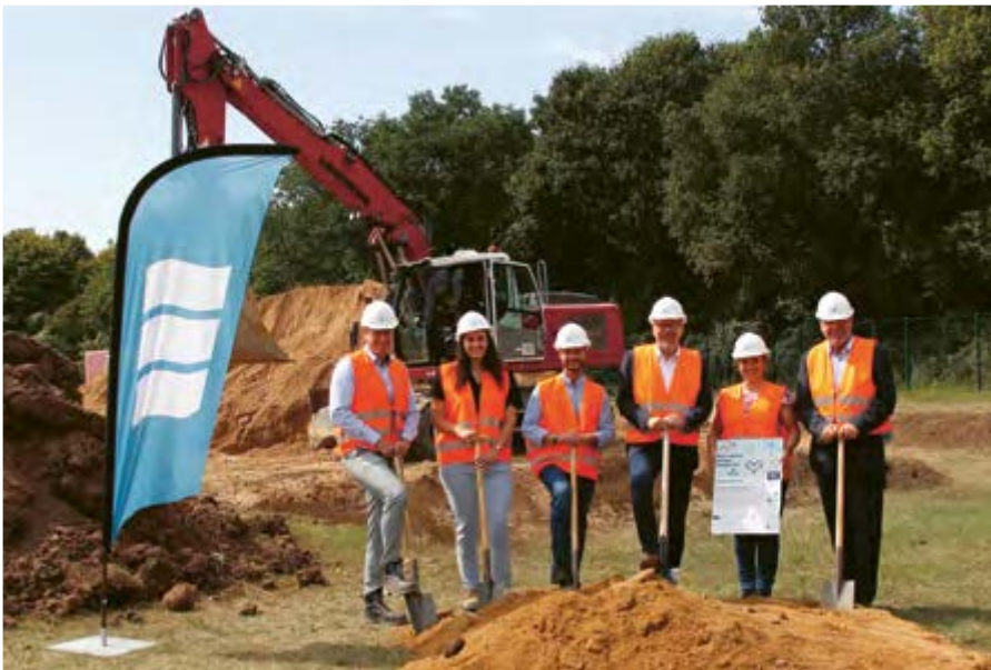
Beim Spatenstich (v. l. n. r.): René Düppen (Bereichsleiter Abwassertechnik), Svetlana Lakicevic (Planungsingenieurin Abwassertechnik), Klaus-Jochen Buir (Betriebsingenieur), Volker Mießler (Bürgermeister der Kreisstadt Bergheim), Anne Kreder (Bauleitung), Prof. Heinrich Schäfer (Erftverbandsvorstand), 25. August
