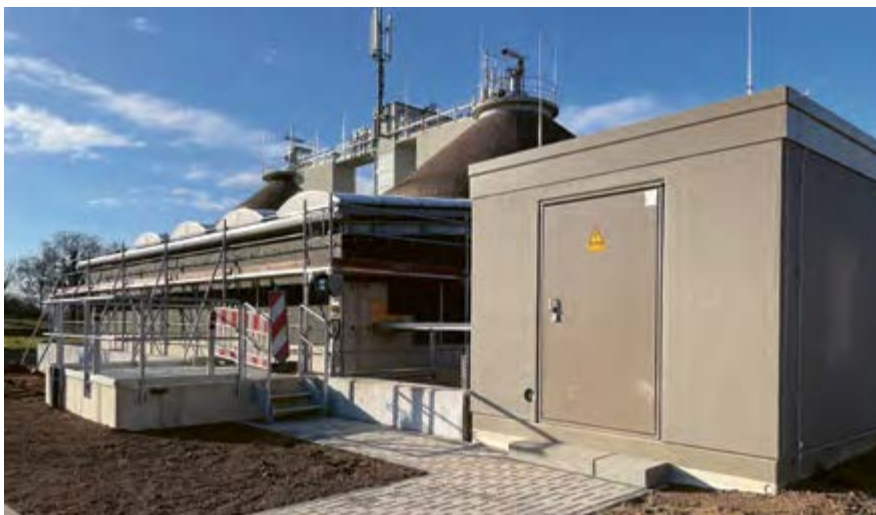
GKW Flerzheim, Membranhalle (Bild oben) und Siebanlage (unten)
