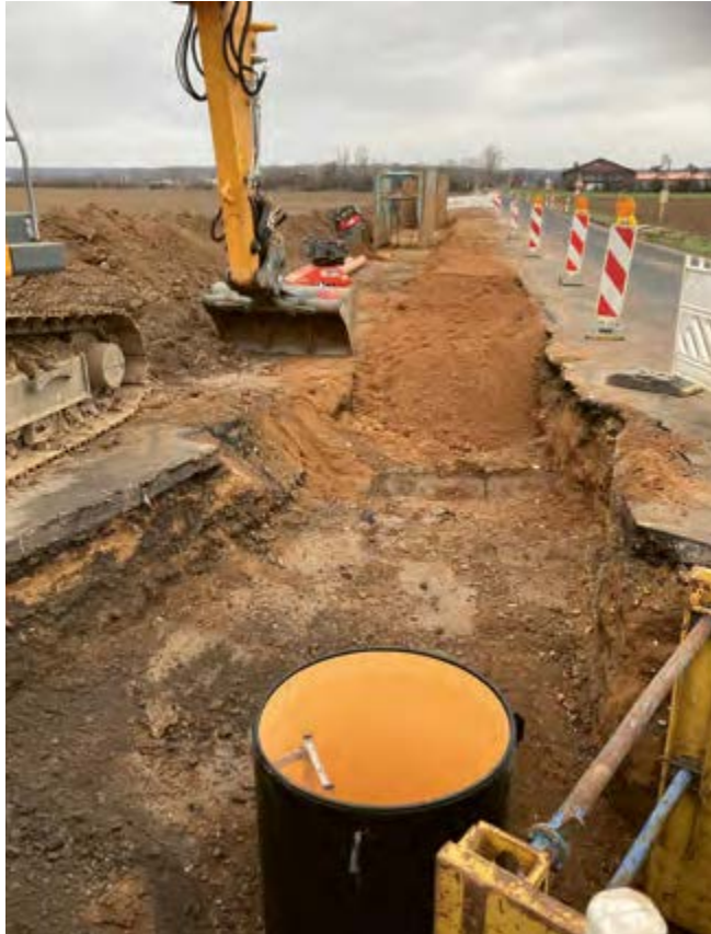
Kanalbau in der Rheindorfer Straße in Müggenhausen
