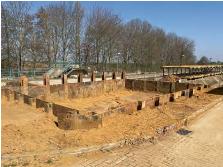
Bau des neuen Pumpwerks auf dem Klärwerksstandort Titz-Rödigen
