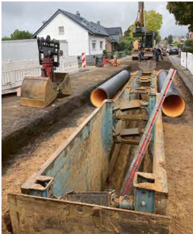
Baugrubenverbau der offenen Kanalsanierung in Alt-Meckenheim
