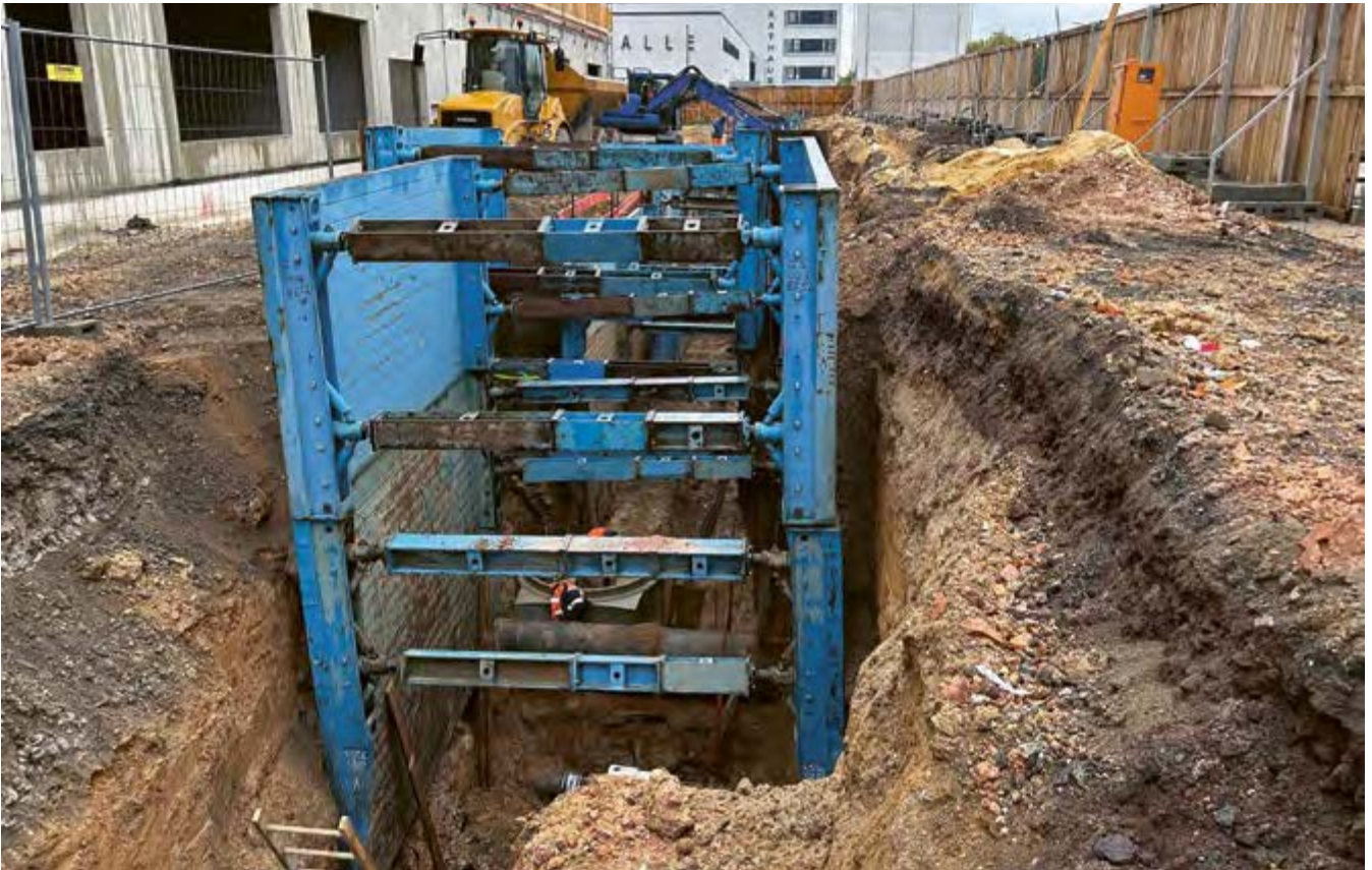
Baugrubenverbau zur Kanalverlegung im Bereich des Schulcampus, Meckenheim
