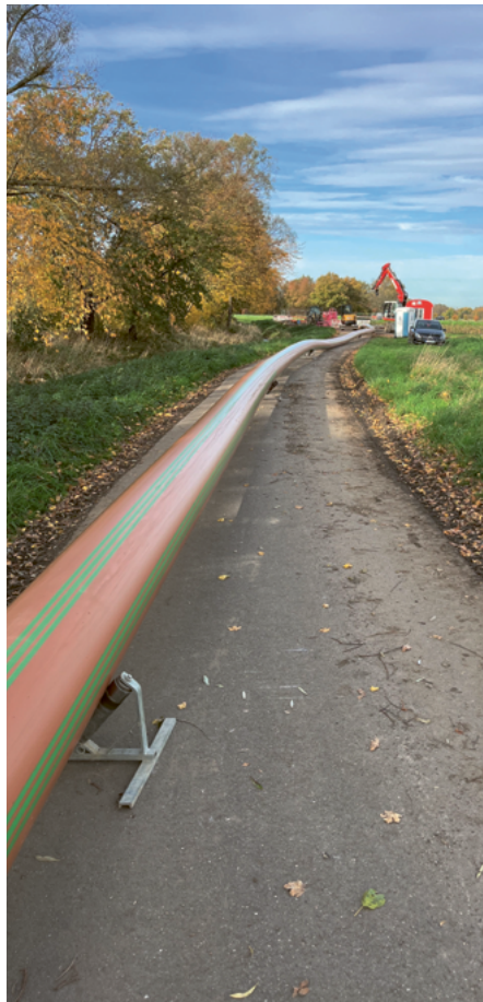
Vorbereitetes Rohr auf Rollen
