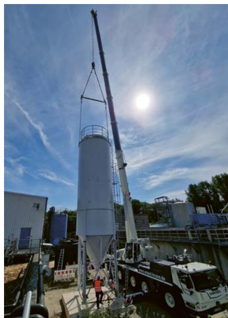
Aufstellen des PAK-Silos
