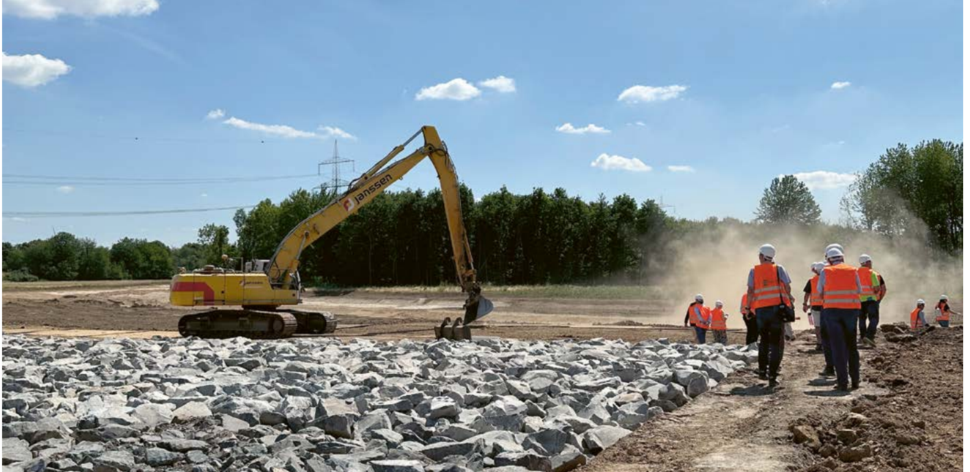
Baustelle Erftumbau Erftstadt-Gymnich
