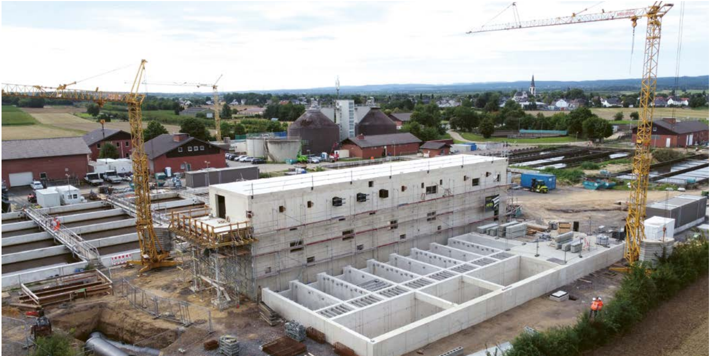
Luftaufnahme der Baustelle an der Membranbelebungsanlage auf dem Gruppenklärwerk Rheinbach-Flerzheim
