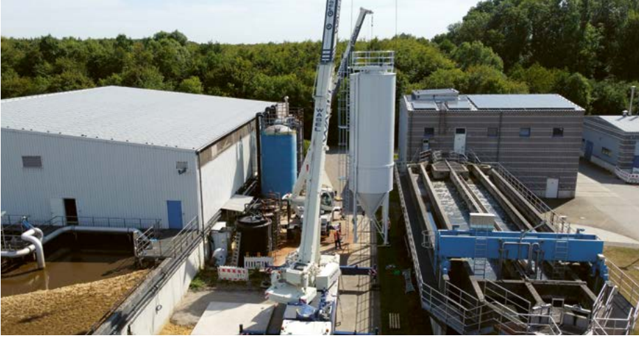
Aufstellen des neuen PAK-Silos GKW Kaarst Nordkanal
