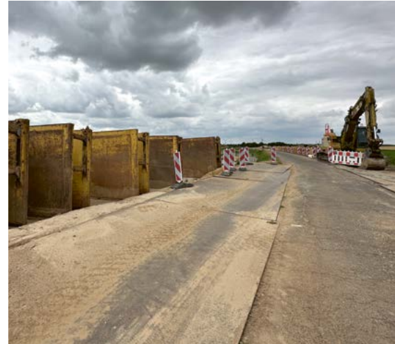
Kanalbauarbeiten zwischen Elsdorf und der Kläranlage Titz-Rödingen
