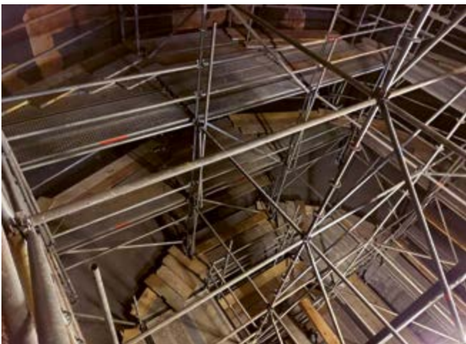
Eingerüsteter Faulturm (innen)
