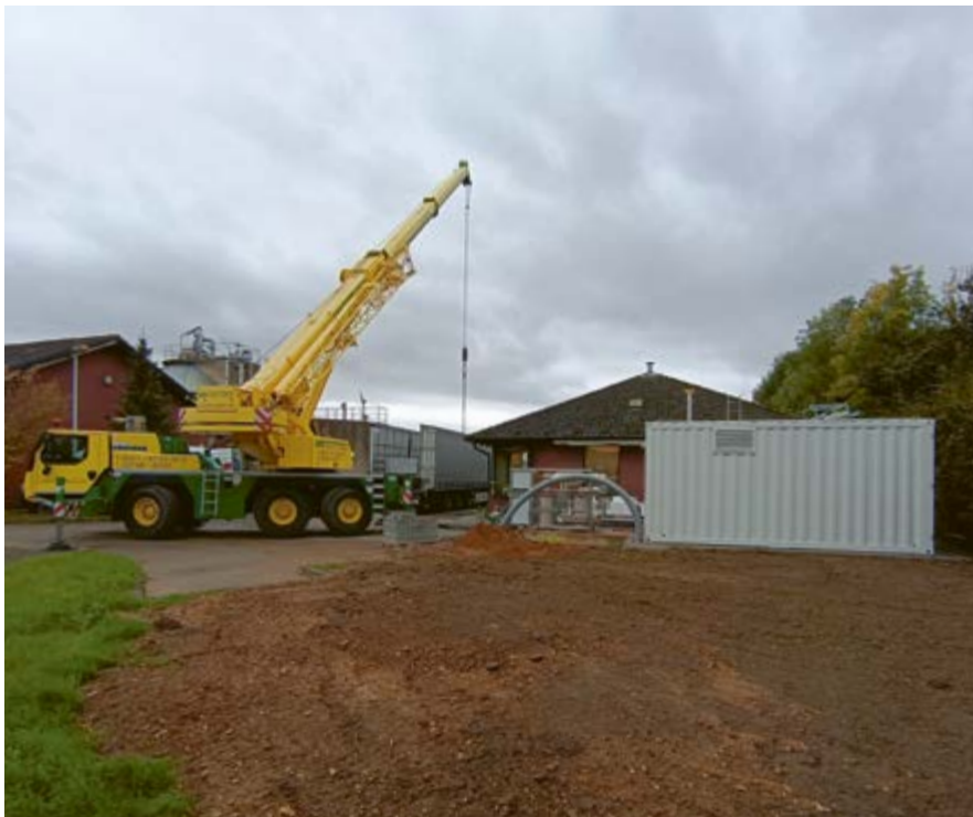
Aufstellen des BHKW-Containers auf der Kläranlage Elsdorf
