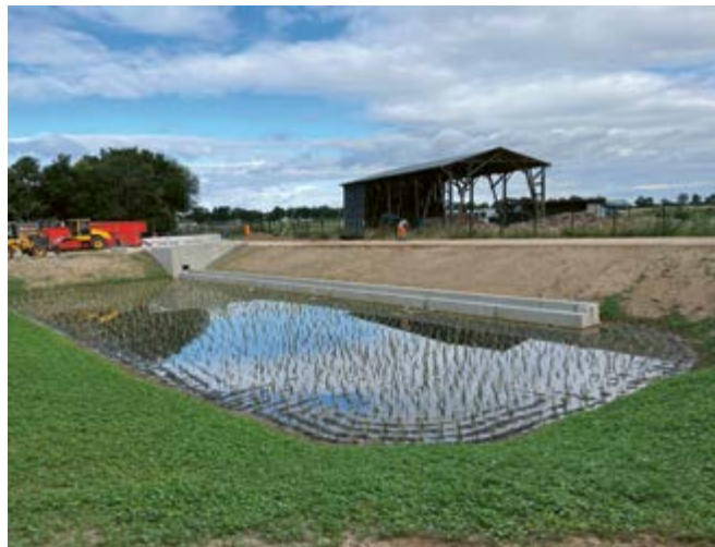
Frisch gesetzte Schilfpflanzen im fertiggestellten Becken in Vettweiß
