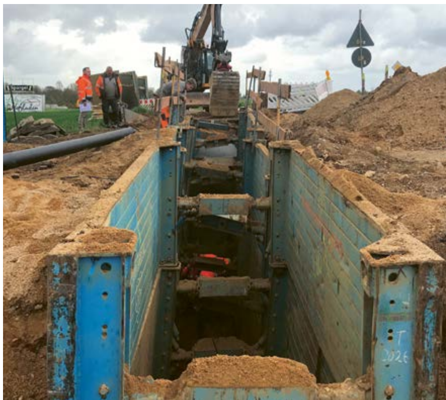
Kanalbauarbeiten am Verbindungskanal Metternich
