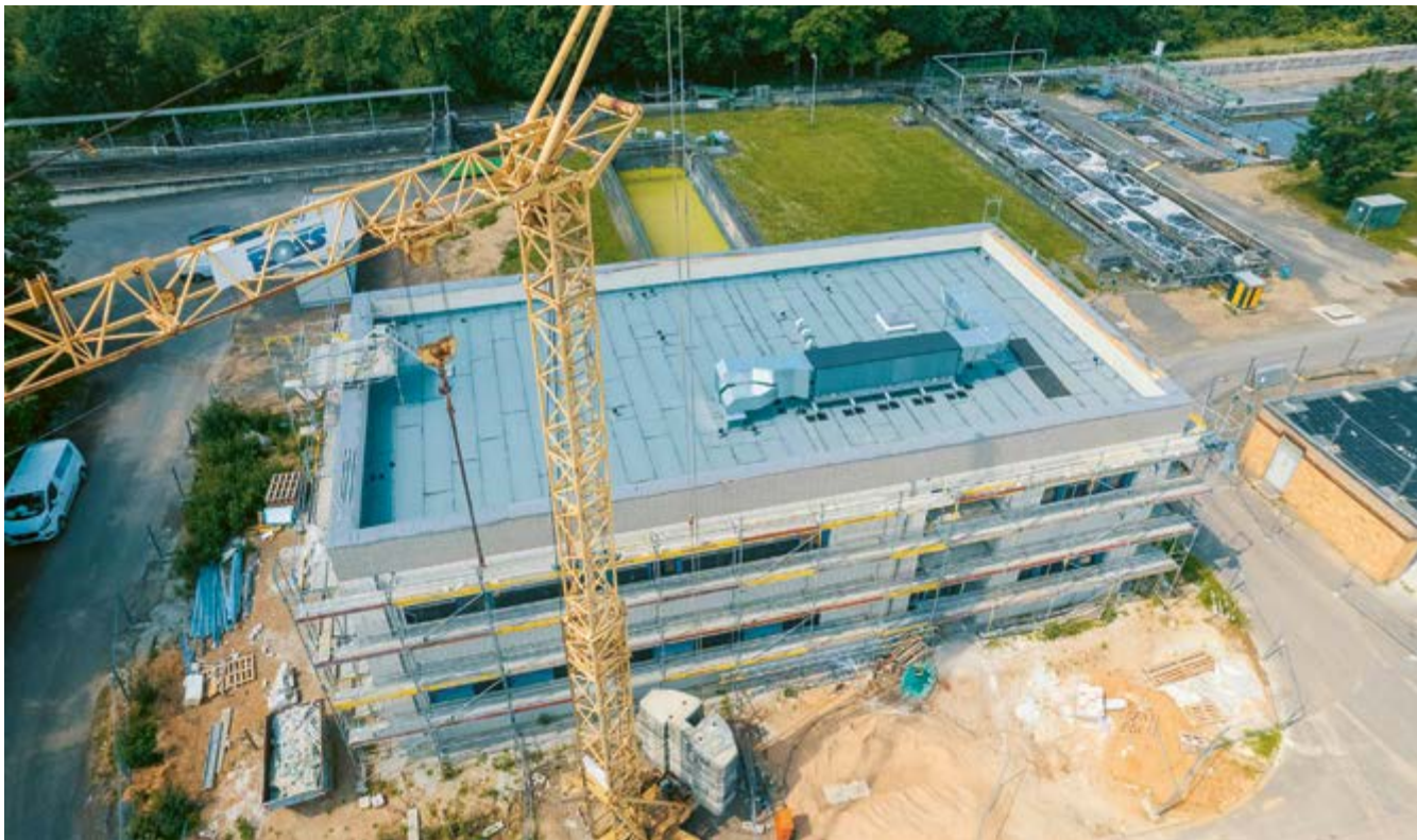
Luftbildaufnahme des neuen Betriebsgebäudes auf der Kläranlage in Erftstadt-Köttingen
