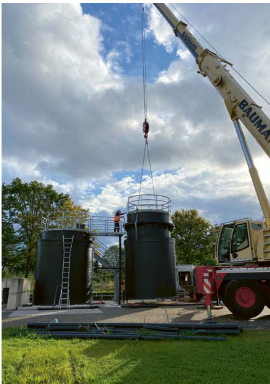
Montage des neuen Fällmittelbehälters in Bornheim
