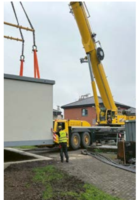
Errichtung eines Netzersatzaggregates (NEA) in Fertigteilbauweise in Flerzheim
