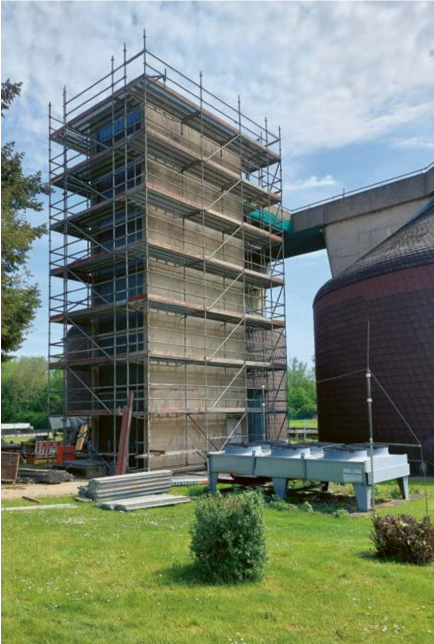
Sanierung des Treppenturms zu den Faultürmen in Grevenbroich
