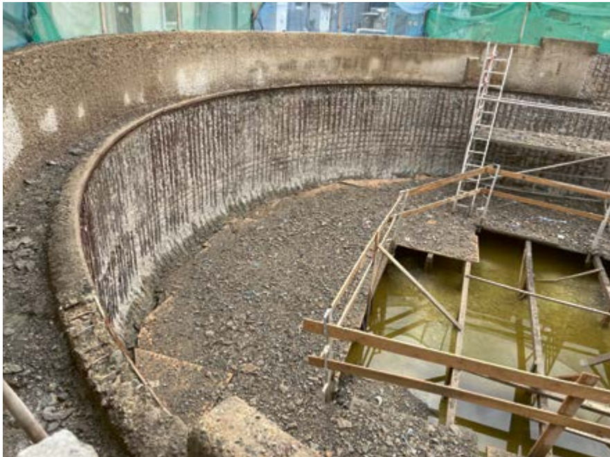
Betonsanierungsarbeiten am Voreindicker in Bergheim-Kenten
