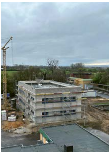
Rohbau des neuen Betriebsgebäudes
