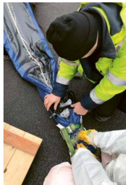
Einzug eines sogenannten GFK-Liners in den zu sanierenden Kanal in Alt-Meckenheim
