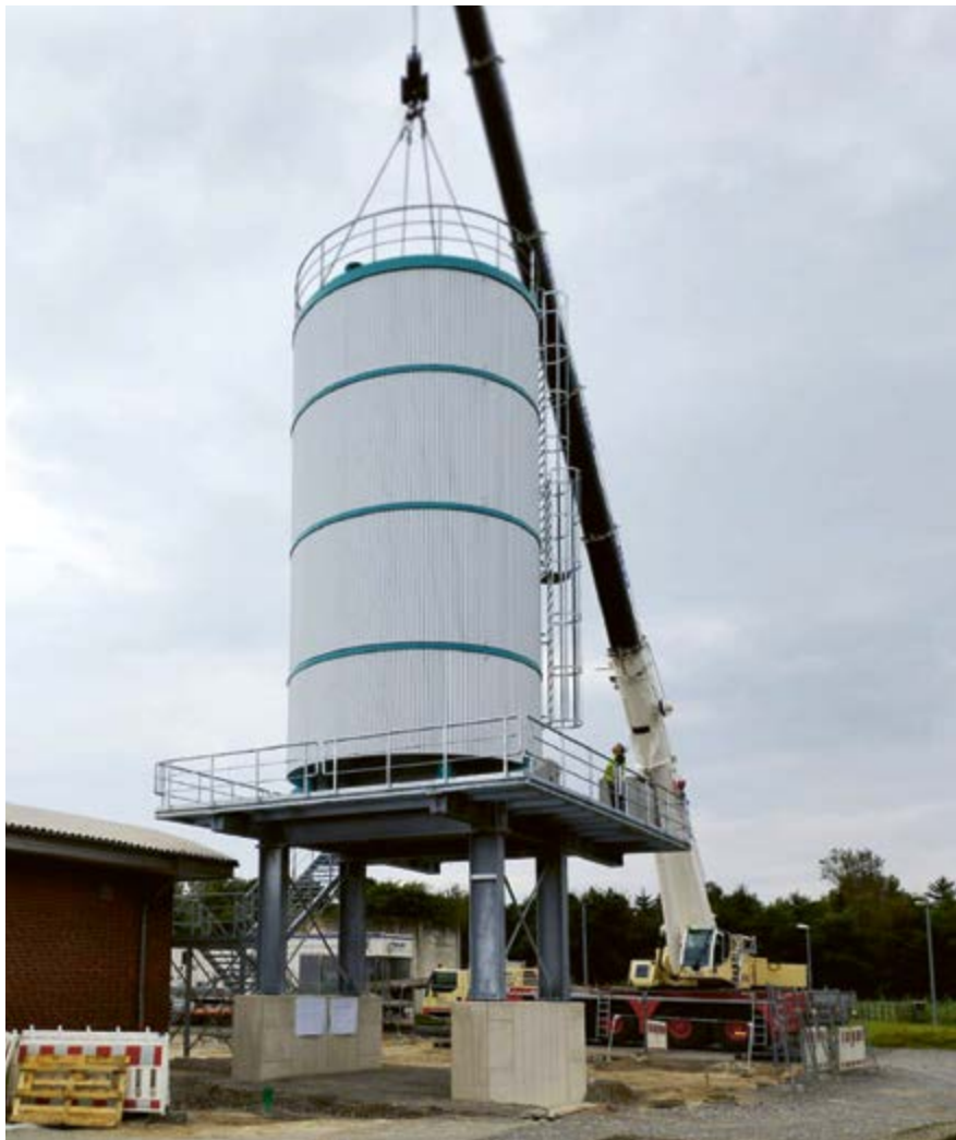
Montage des Hochsilos auf dem GKW Grevenbroich
