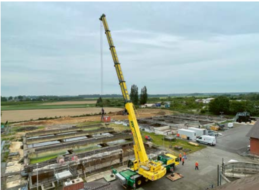
Autokran beim Versetzen einer Räumbrücke auf dem GKW Rheinbach-Flerzheim
