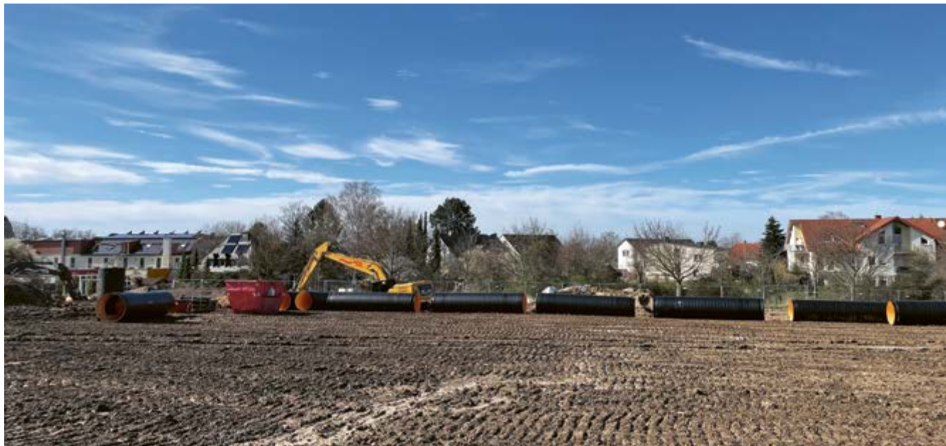
Verlegung von PE-HD-Kanalrohren im Rahmen der Erschließungsmaßnahmen im Neubaugebiet Weinberger Gärten, Meckenheim
