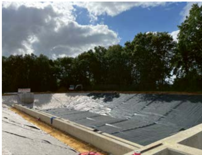
Verlegung der Kunststoffdichtungsbahn zur Beckenabdichtung (Vettweiß)
