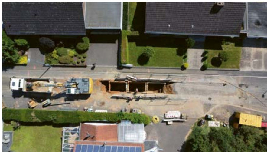
Offene Kanalsanierung im Bereich Schleidener Straße in Weilerswist-Lommersum
