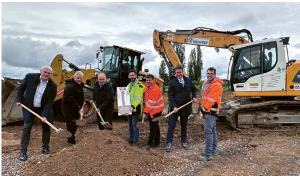
Am Spatenstich auf dem Gruppenklärwerk Rheinbach-Flerzheim (v.l.n.r.): Landrat Sebastian Schuster (Rhein-Sieg-Kreis), Matthias Börger (MUNV NRW Abteilungsleiter Wasserwirtschaft), Prof. Heinrich Schäfer (Vorstand Erftverband), Eric Gramlich (Ingenieurbüro Tuttahs & Meyer), Torsten Bölinger (Technischer Beigeordneter Rheinbach), René Düppen (Bereichsleiter Abwassertechnik, Erftverband), Lars Fischer (Planungsingenieur Erftverband), 29. Mai
