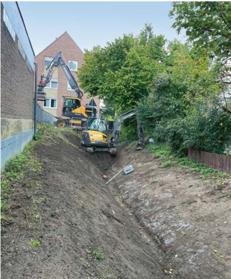
Das Ausbaggern von Gräben verursacht in eng bebauten und schlecht zugänglichen Bereichen einen erheblichen Aufwand
