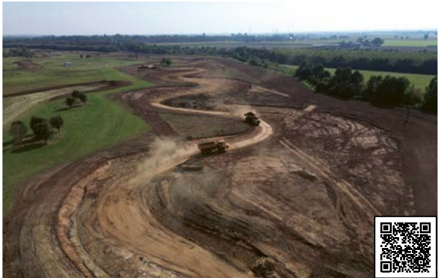
Erdarbeiten Mitte September auf der Weidefläche in der Erftaue
