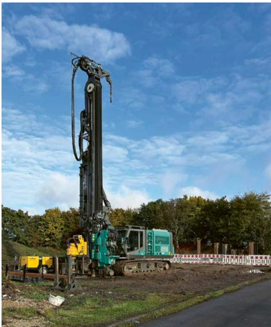
Kanalbauarbeiten am Verbindungskanal Metternich
