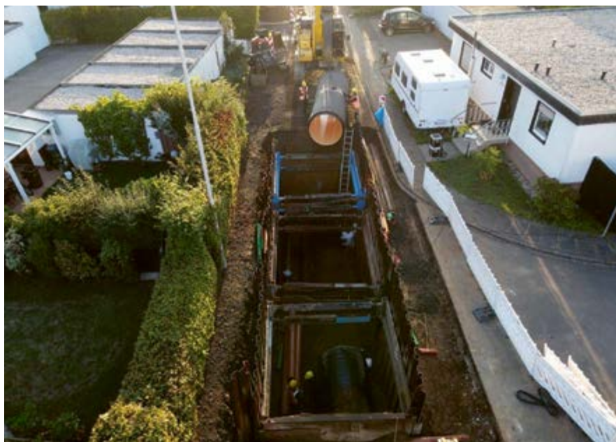
Herstellung eines PE-HD-Kanals in offener Bauweise im Ortsteil Merl
