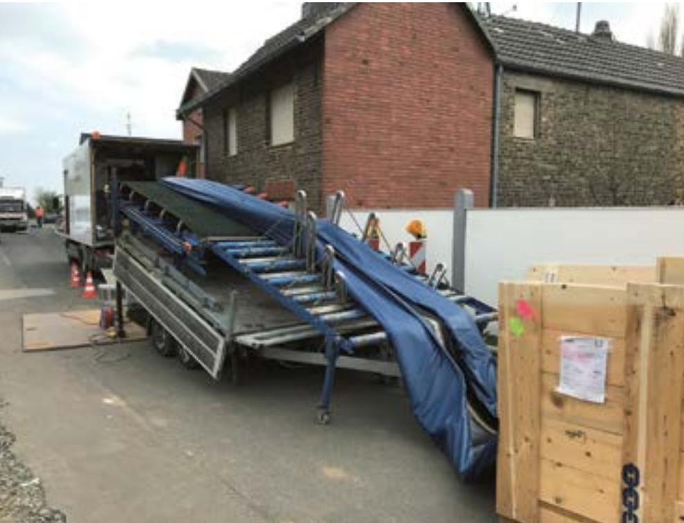
Einzug eines Kanalliners in den Bestandskanal
