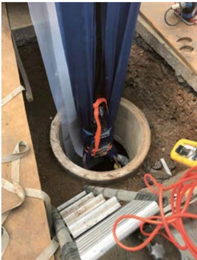
Einzug eines Kanalliners in den Bestandskanal
