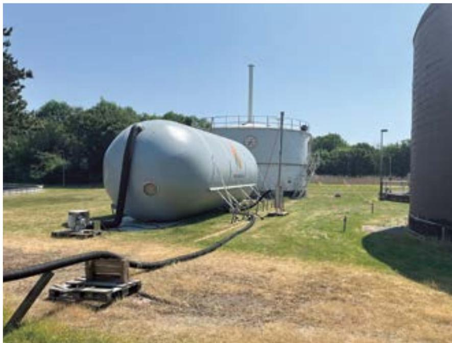
Sanierung des Gasbehälters auf dem Gruppenklärwerk Grevenbroich, Aufbau eines provisorischen Speichers während der Bauphase
