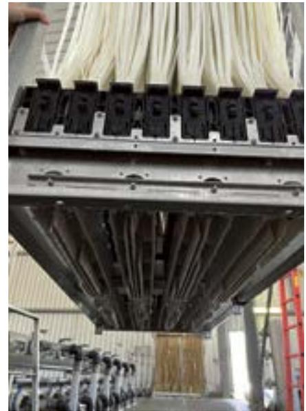
Austausch von Membranfiltern auf dem Gruppenklärwerk Nordkanal
