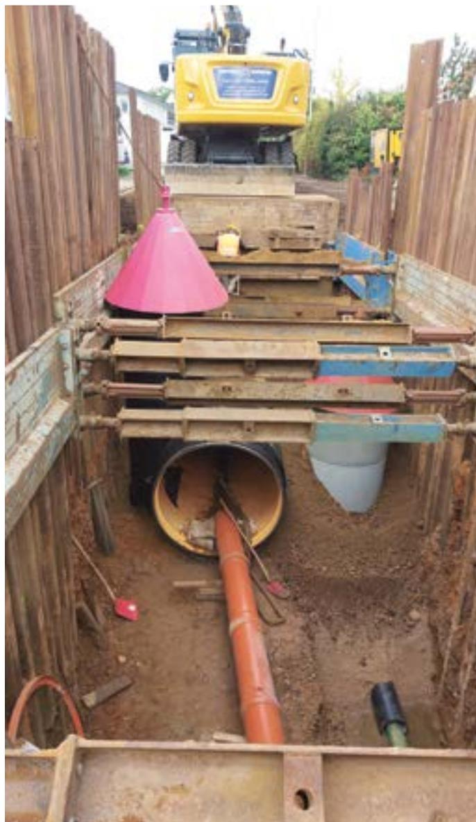
Einbau eines PE-HD-Kanals in offener Bauweise
