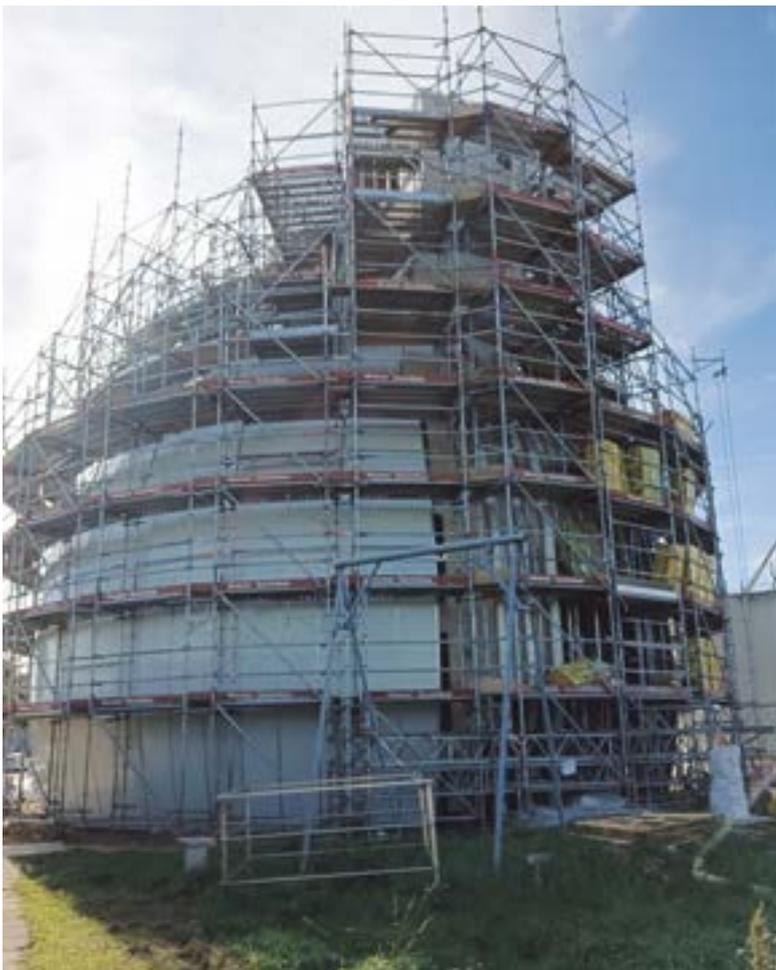
Sanierung des Faulturms mit Wärmedämmung
