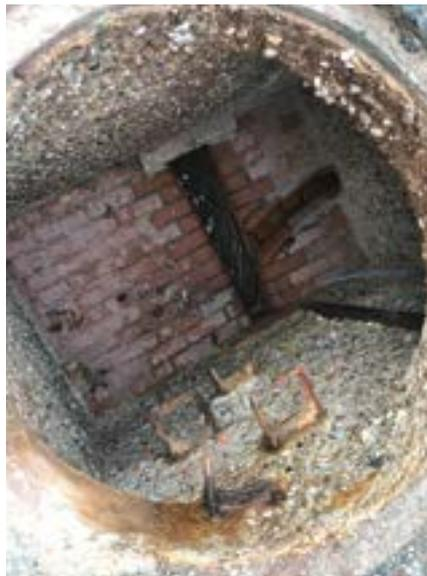
Betonkorrosion im Bauwerksschacht
