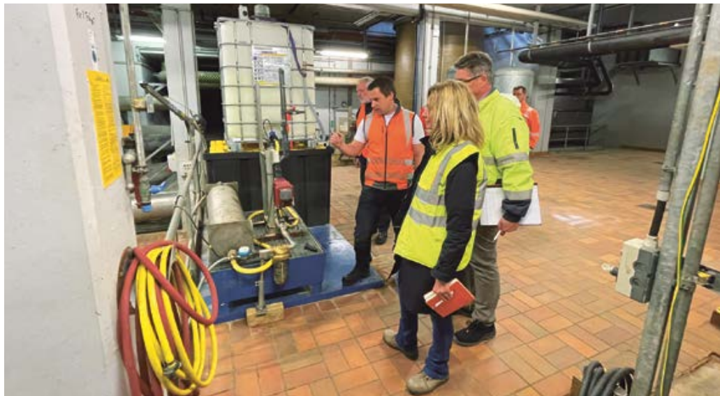
Kläranlage Weilerswist, Audit 2023
