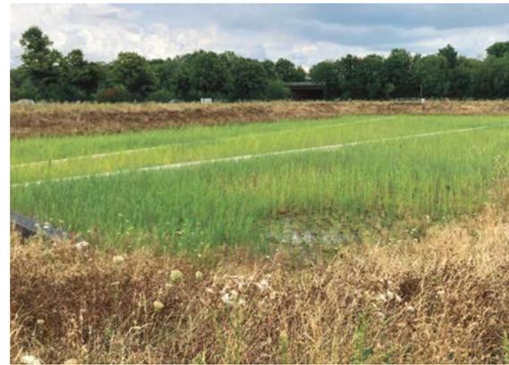
Retentionsbodenfilterbecken nach der Aufwuchsphase
