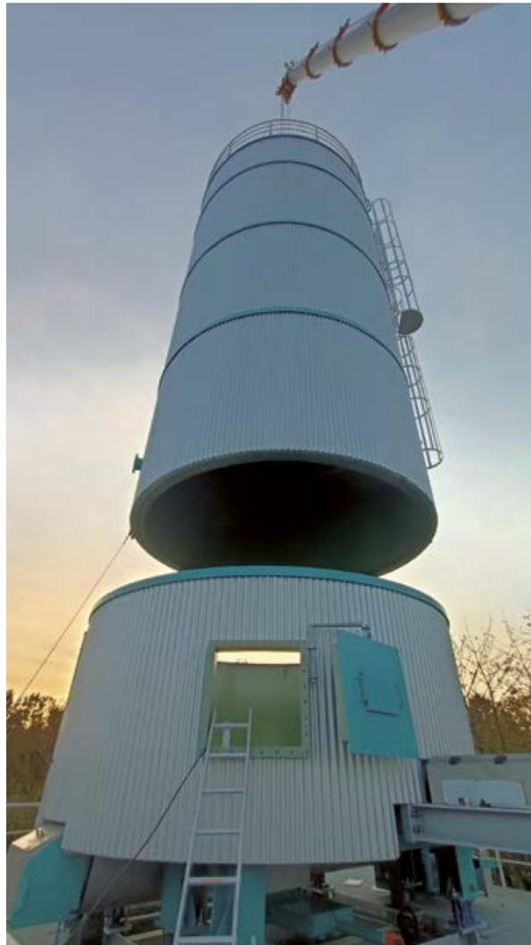
Aufbau des Schlammsilos mittels Autokran
