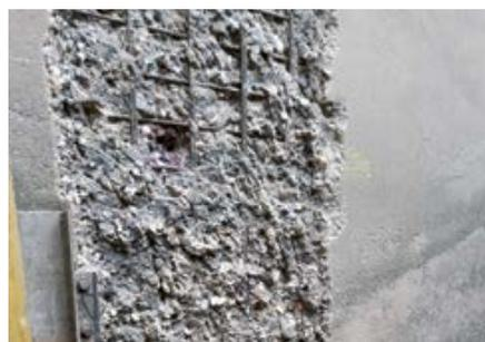
Betonabtrag des geschädigten Betons im Zulaufbauwerk
