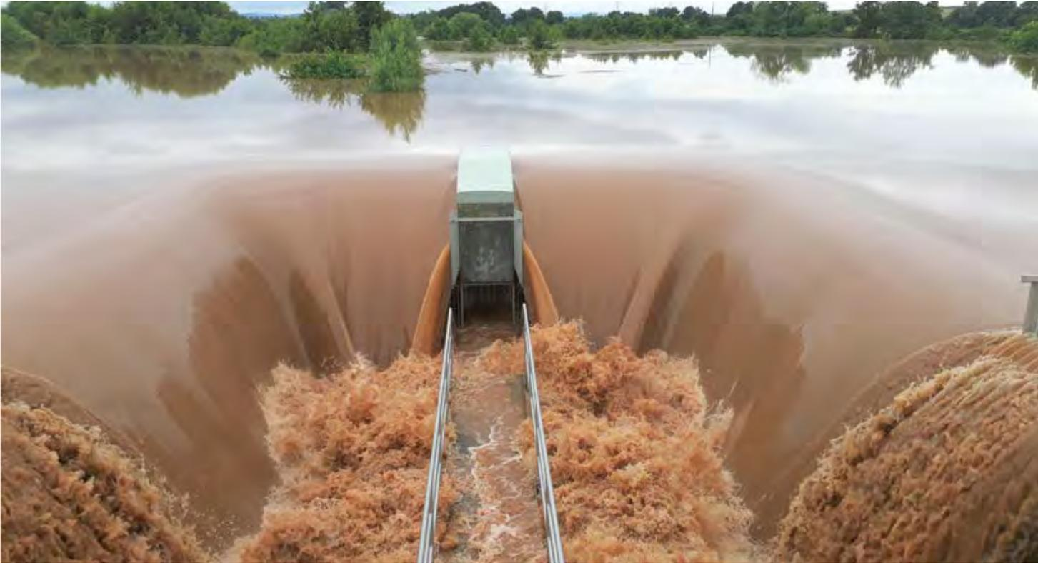
Das Hochwasser strömt über die Schwelle der Hochwasserentlastung des HRB Niederberg
