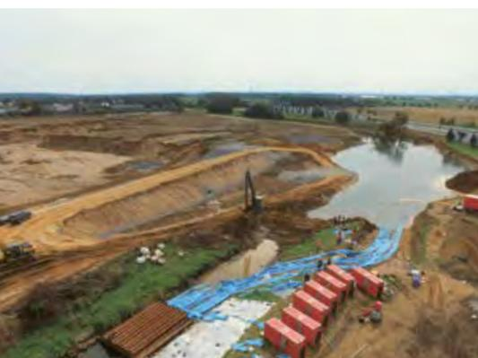
Überleitung der Erft in Ertstadt-Blessem mittels Pumpen; im Hintergrund fertiger Steinwall, der den Erosionsbereich absperrt
