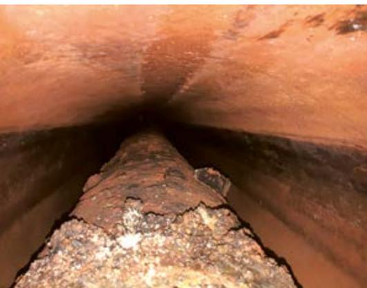
Blick in das Schutzrohr der havarierten Druckleitung
