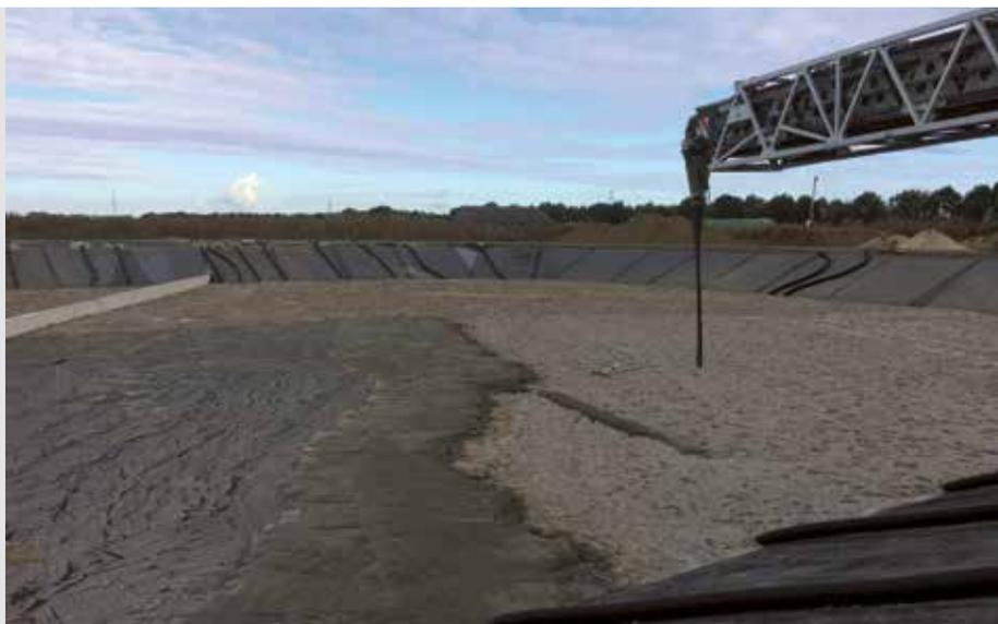
Einbau der Aktivkohle in den Retentionsbodenfilter in Rheinbach, 2020
