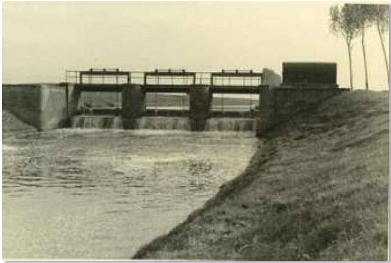
Wehr W I im Flutkanal
