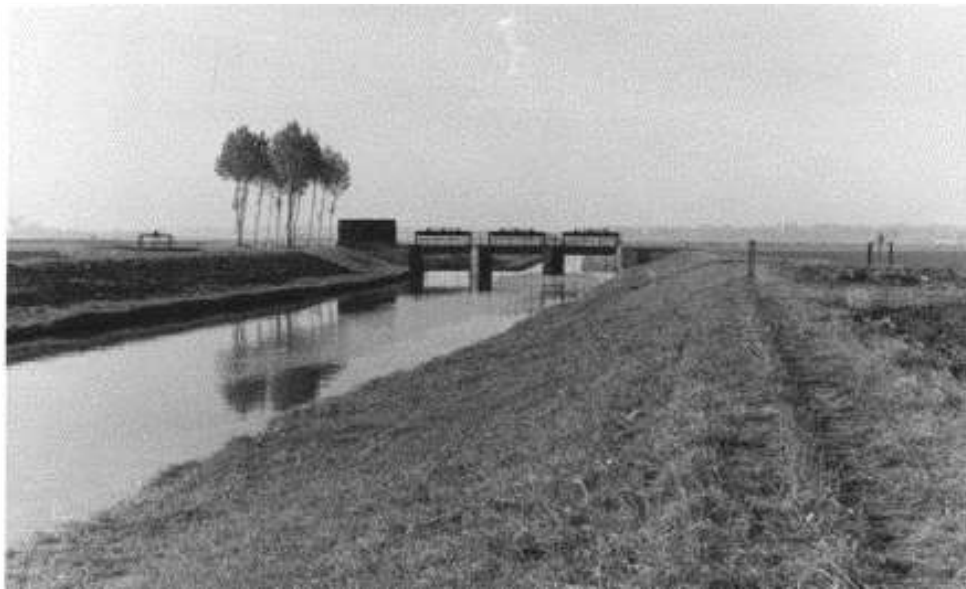
Wehr W I im Flutkanal
