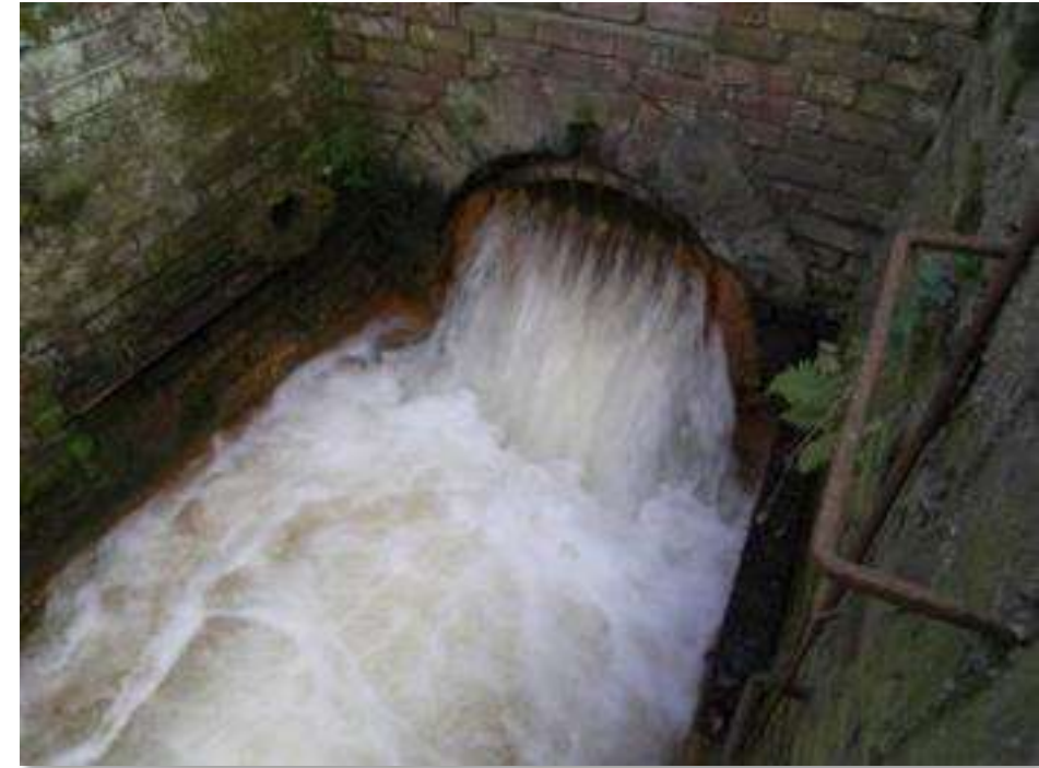
Mundloch des Burgfeyer Stollens
