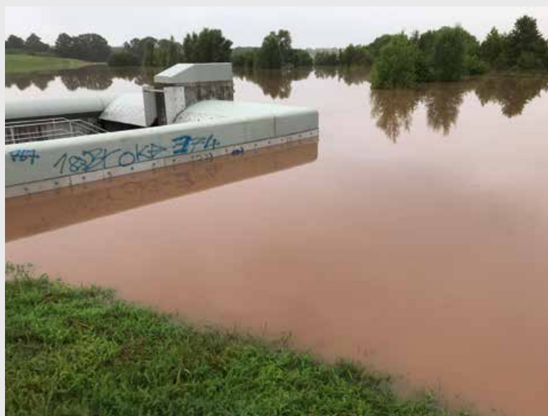
HRB Niederberg vor dem Anspringen der Hochwasserentlastung
