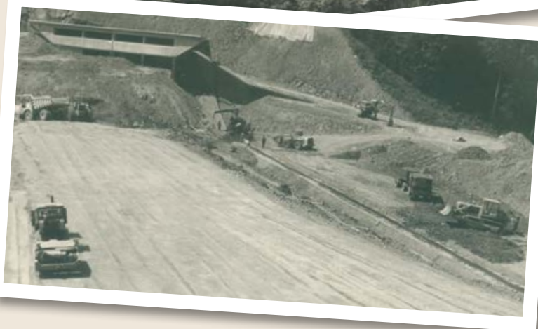
Innenkernichtung und Steinschütt-damm im Bau, 1974/1975
