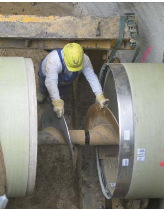
Meckenheim – Kreuzung der Bahntrasse mittels Schneckenbohrverfahren
