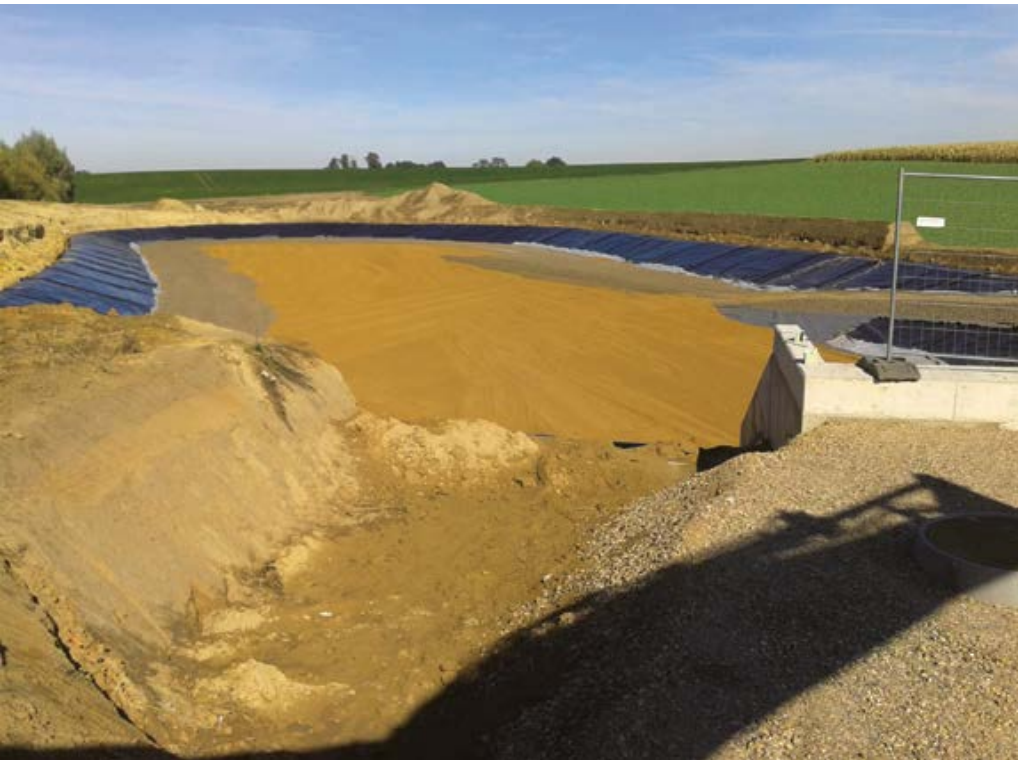
Rommerskirchen – Regenrückhaltebecken Sinsteden
