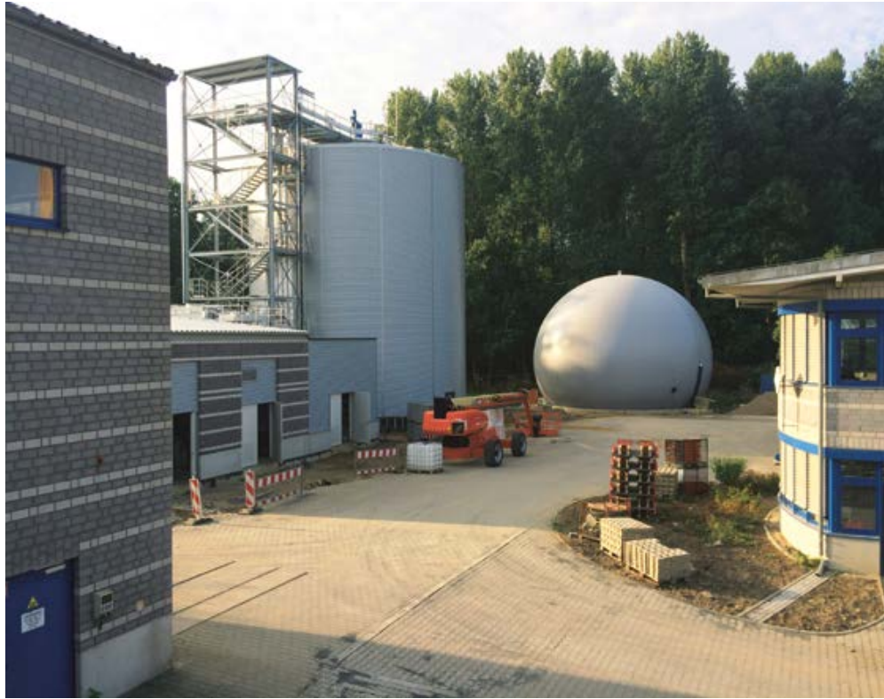
GKW Kaarst-Nordkanal – Gasbehälter, Faulturm und Maschinengebäude
