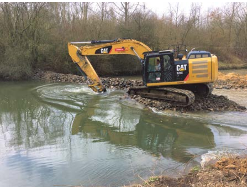
Bagger beim Bau einer Buhne zur Strömungslenkung
