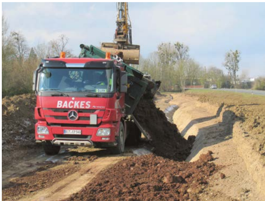
Einbau der innenliegenden Lehmdeichung in die rückverlegte Verwallung
