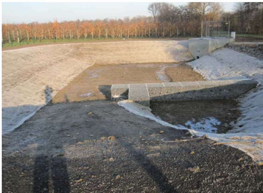
Meckenheim – Regenrückhaltebecken Ersdorf
