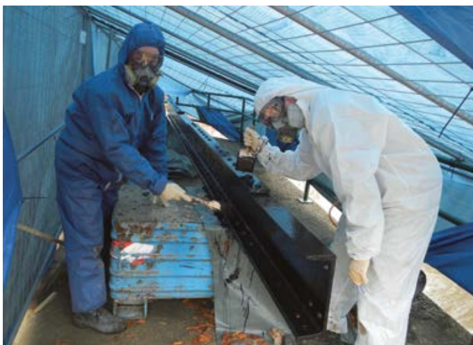
Schutzlackierung eines Stahlträgers vor Ort
