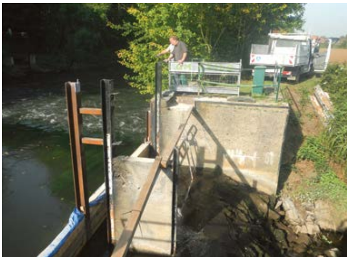
Das Schütztafelwehr 6.1 während der Sanierungsarbeiten
