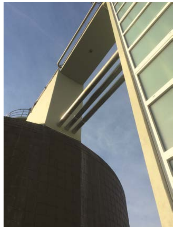
GKW Rheinbach-Flerzheim – Sanierter Faulbehälter
