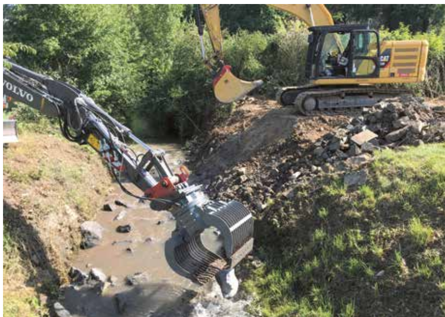
Bagger beim Aufbau der Sohlengleite bei Hochkirchen
