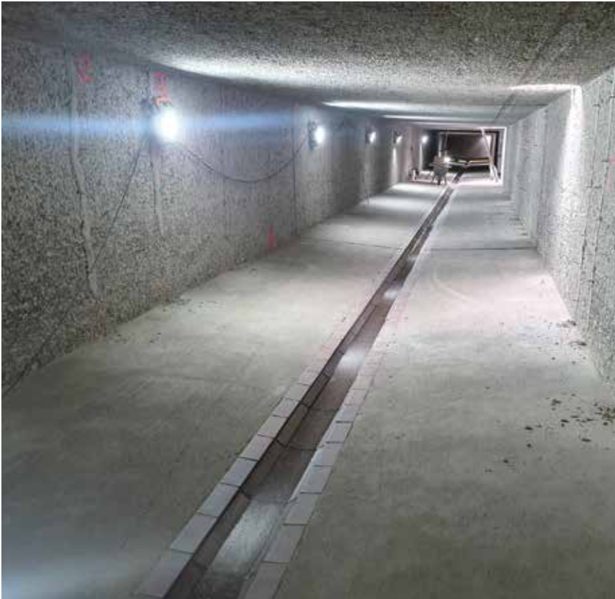
RÜB Frenzenhofstraße nach Abtrag der geschädigten Betonschichten
