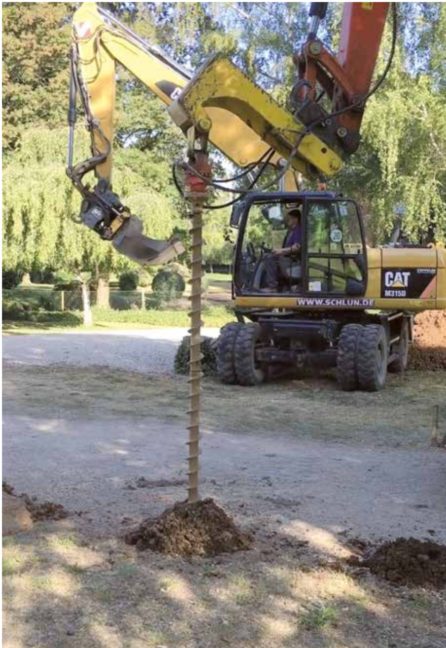
Vorbereitende Arbeiten für die Kanalsondierung
