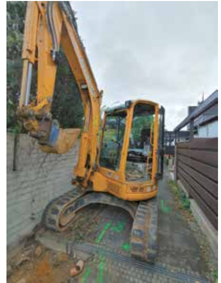
Bauarbeiten unter beengten Verhältnissen
