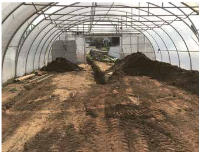
oben: Kanalgraben der Druckrohrleitung Floisdorf unten: Verlegung der Druckrohrleitung durch Gewächshaus einer Gärtnerei
