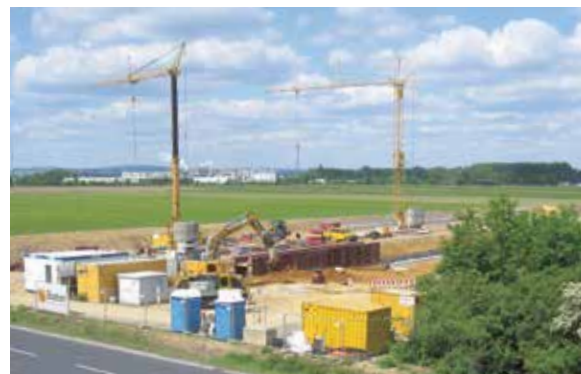
Blick auf den im Bau befindlichen RBF
