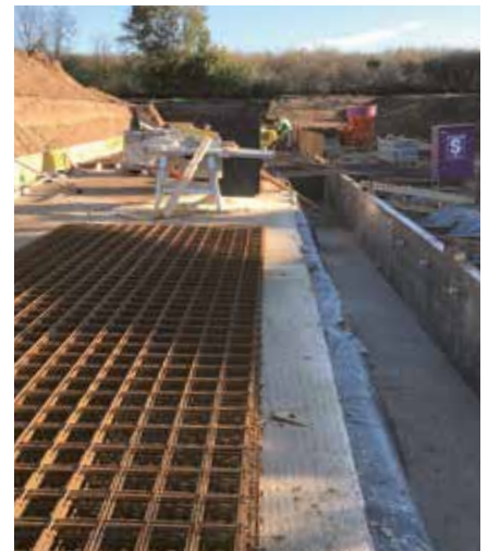
Betonarbeiten am RBF
