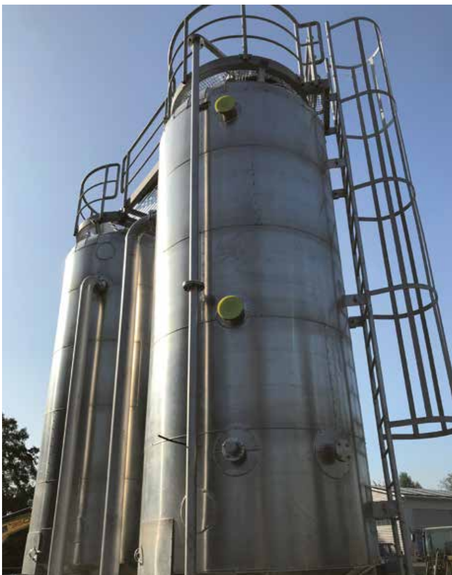
Edelstahlsilos mit granulierter Aktivkohle
