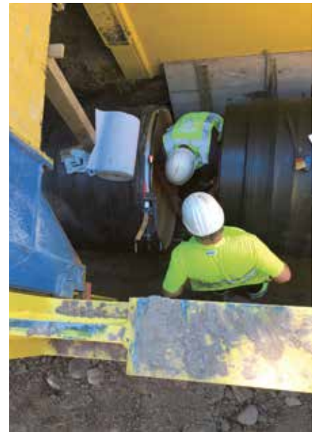
Verlegung der Wickelrohre vor dem Verschweißen
