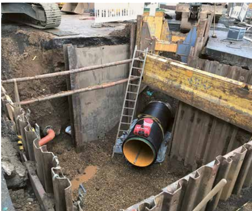
Zielgrube des Kanals vor dem Einbau eines Schachtbauwerkes
