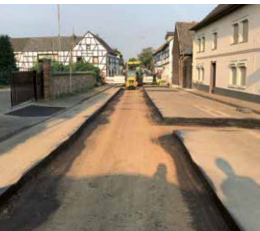
Wiederherstellung der Straße nach Kanalsanierung
