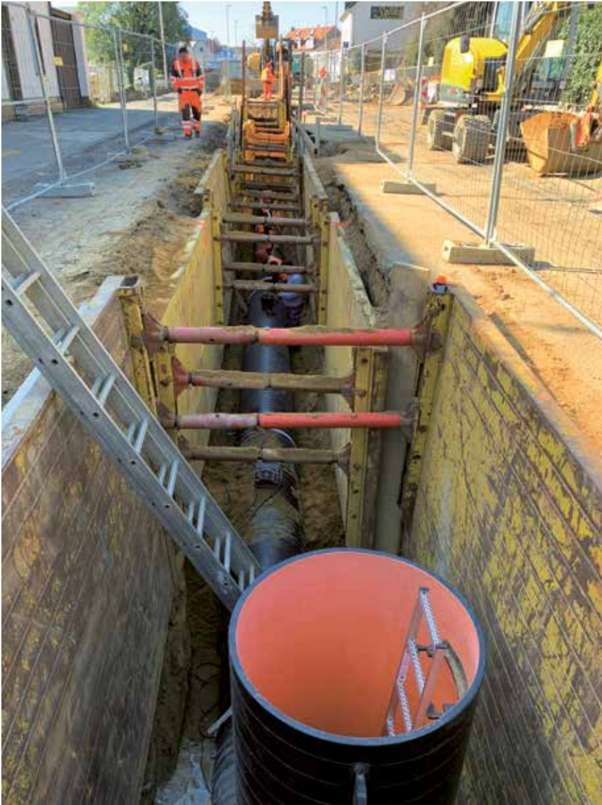
Kanalbauarbeiten in der Bonner Straße
