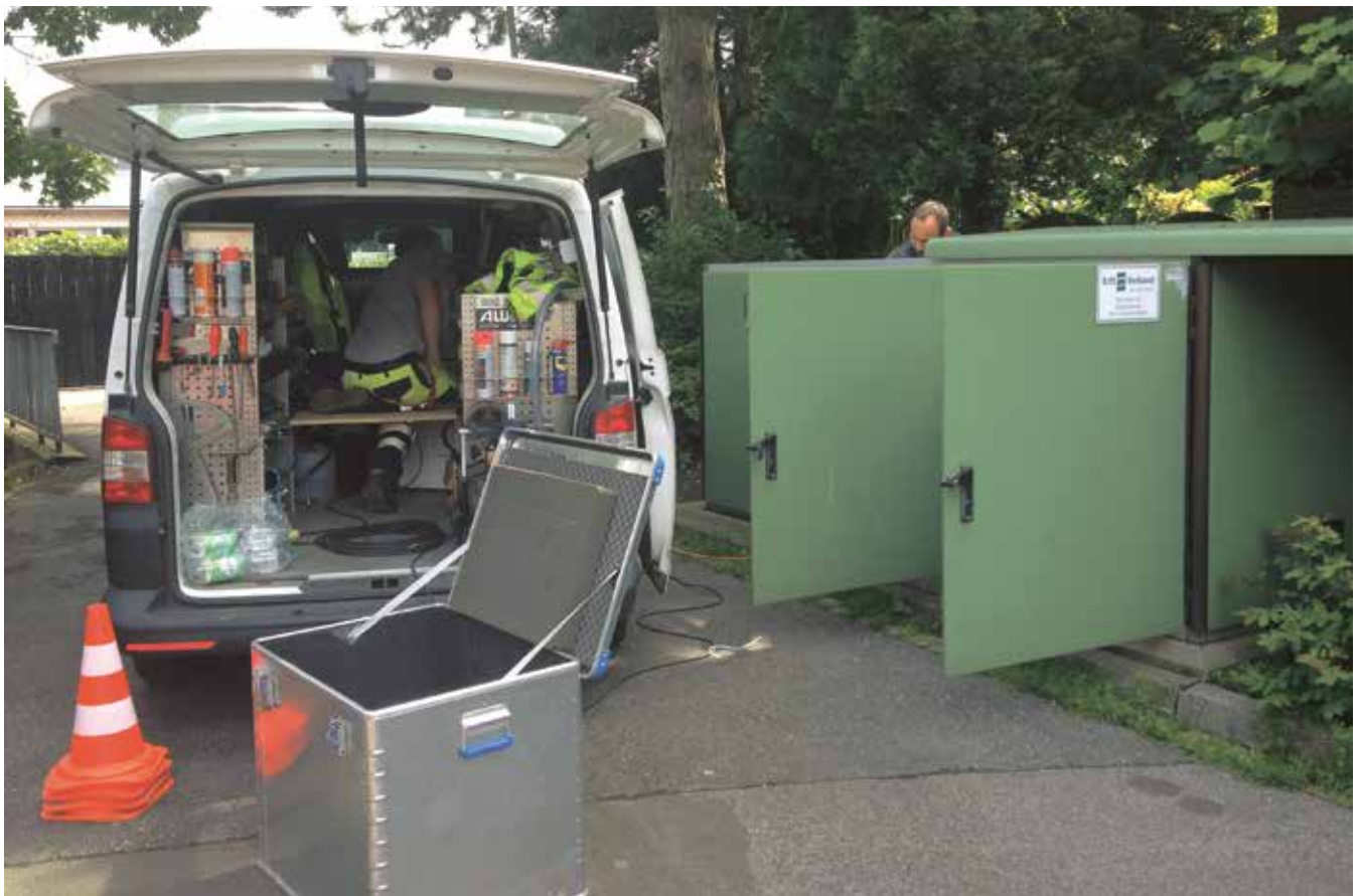
Wartungsarbeiten am Brunnen 47 in Kleinenbroich
