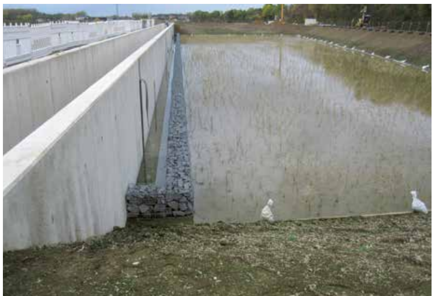
RBF nach Bepflanzung mit Schilf in der Anwuchsphase
