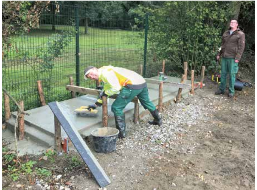
Mitarbeiter der GM Münchrath bei Betonarbeiten für die neuen Steuerschranke der Wehranlage W8
