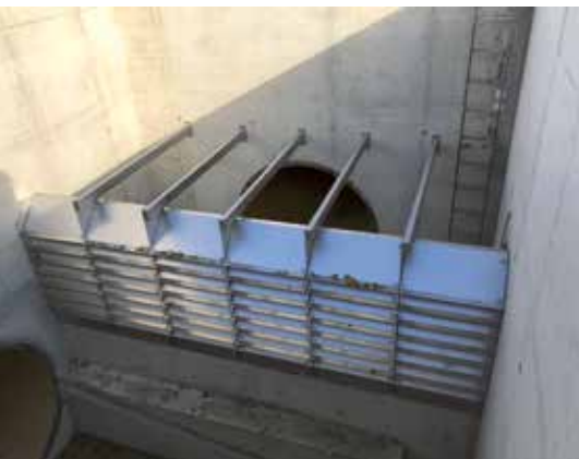
Lammellenklärer nach Einbau
