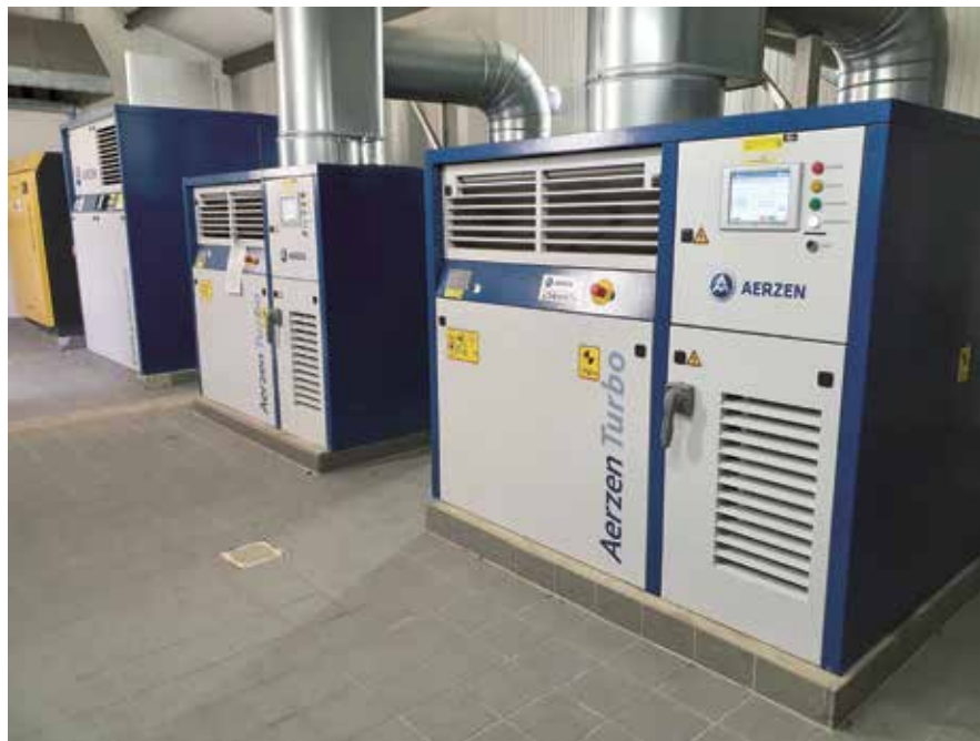
Neue Belüftungsaggregate auf dem GWK Bergheim-Kenten
