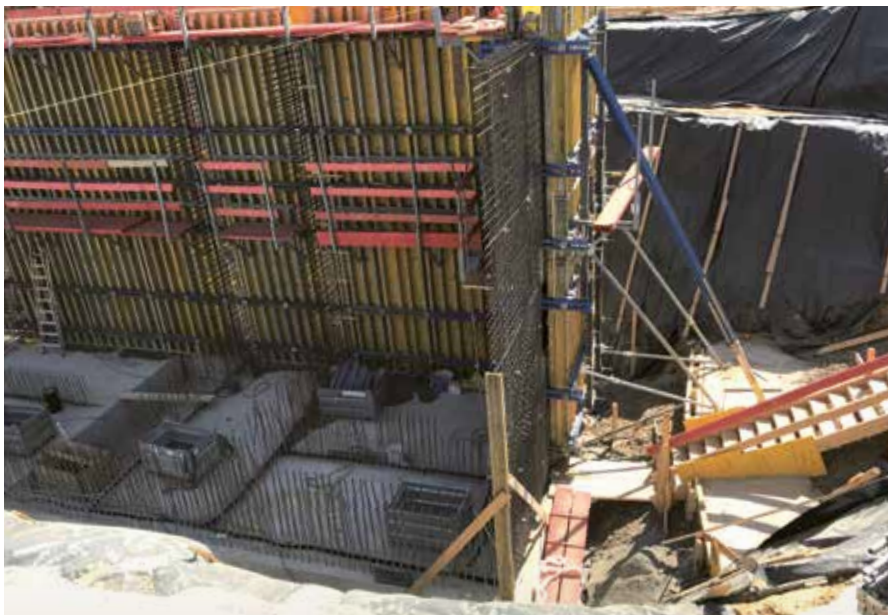
Schalarbeiten am Regenklärbecken
