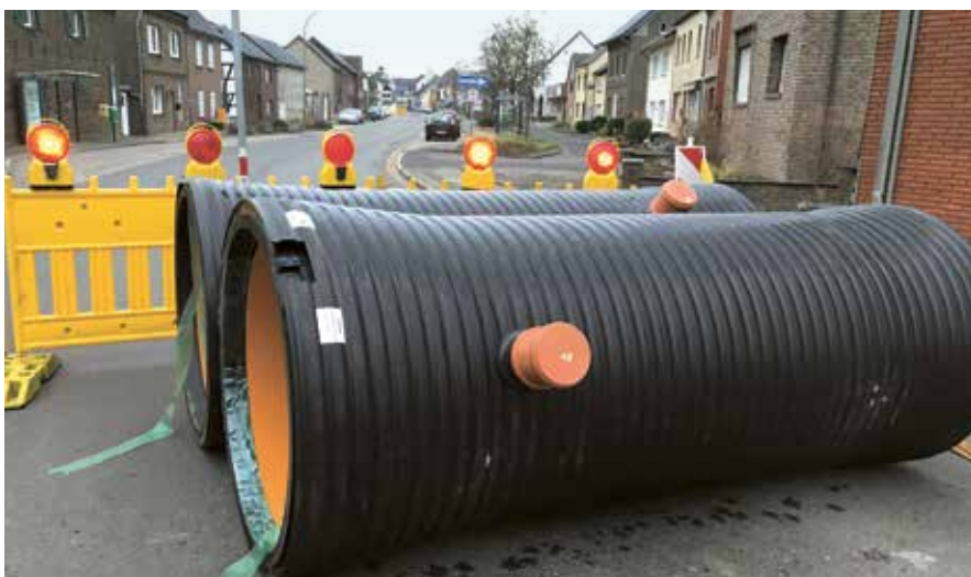
PE Wickelrohr nach Lieferung auf der Baustelle
