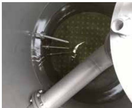
Blick ins Innere eines Silos
