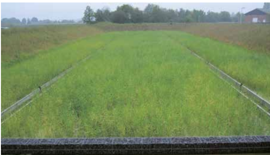
oben: Verlegung der Beschickungsrinnen am RBF; unten: Anwuchs-Phase nach Schilfeinsatz ins RBF
