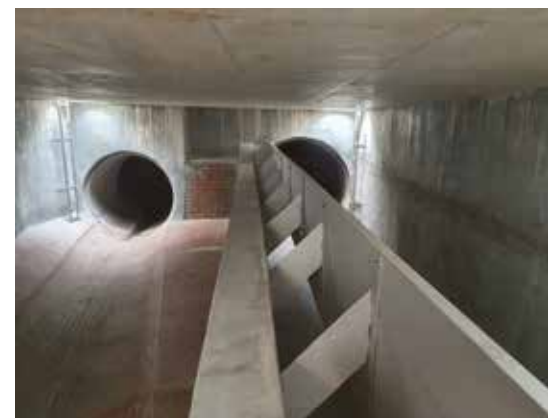
oben: RRB Torfstecher Weg – Tauchwand vor Ertüchtigung; unten: Tauchwand nach Ertüchtigung
