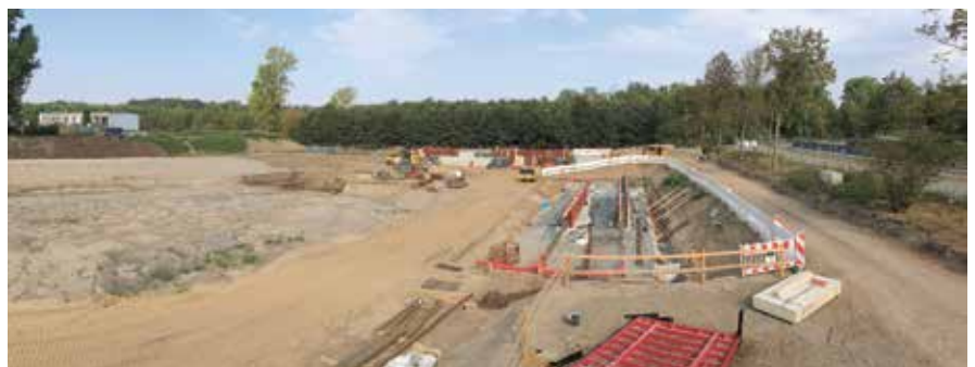
Panoramabild von der Baustelle des RBF Wiesenstraße
