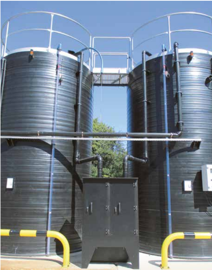
Zwei neue Fällmittelbehälter auf der KA Auenheim
