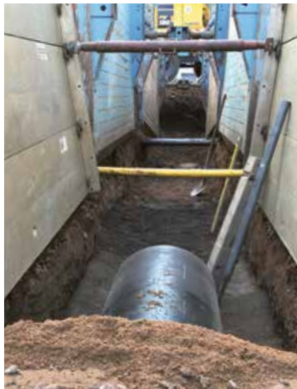
Foto aus Kanal der offenen Kanalsanierung
