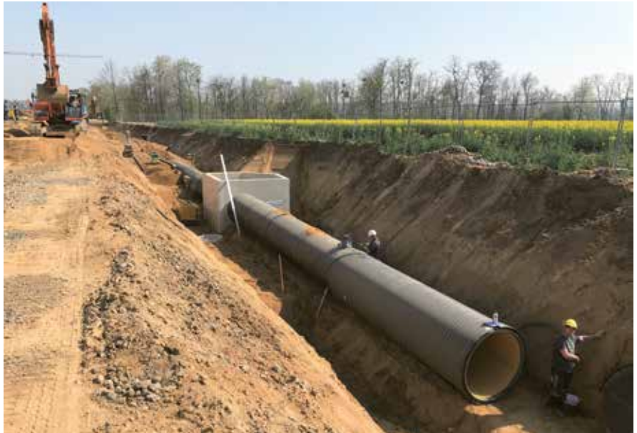
Verlegung des Hauptkanals für das Baugebiet Römergärten
