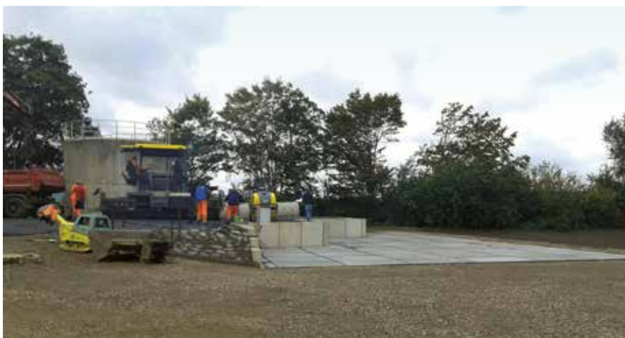
Bauarbeiten an der Containerverladestation
