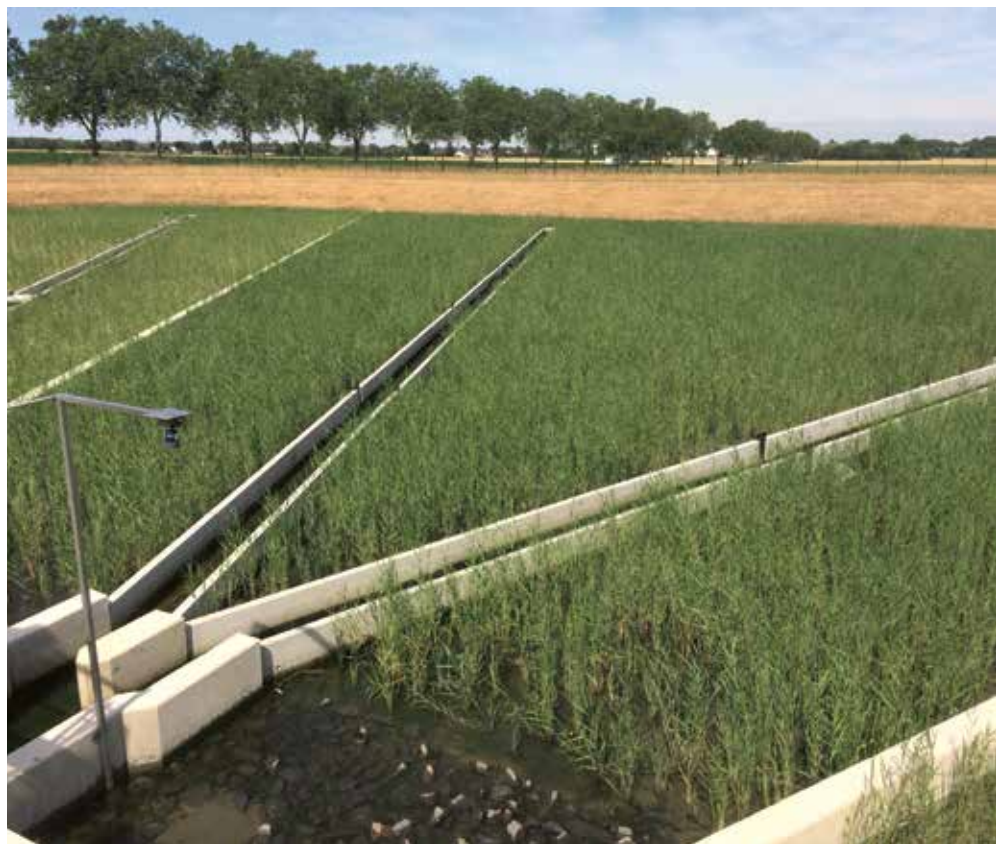
Retentionsbodenfilter Rheinbach nach Anwuchs der Schilfpflanzen
