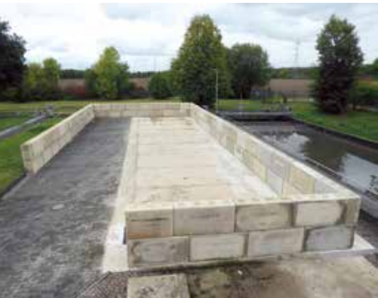
Zwischenlager für Klärschlämme im Bau
