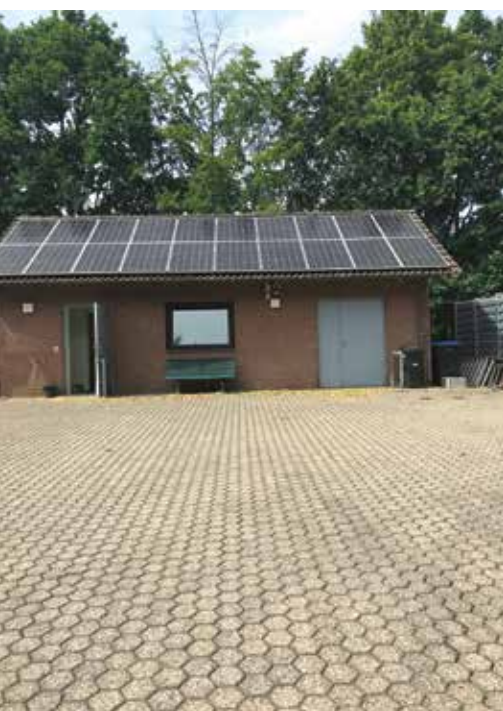
Photovoltaikanlage auf der Kläranlage Embken
