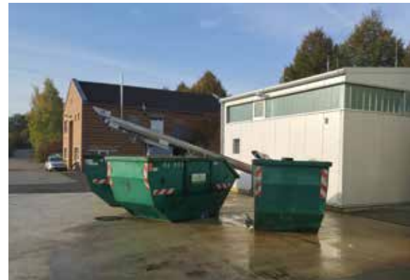
Halle der maschinellen Schlammwässerung
