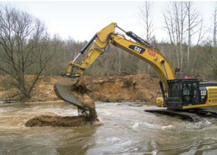
Bagger beim Schütten einer Insel als Strukturelement in der Erft
