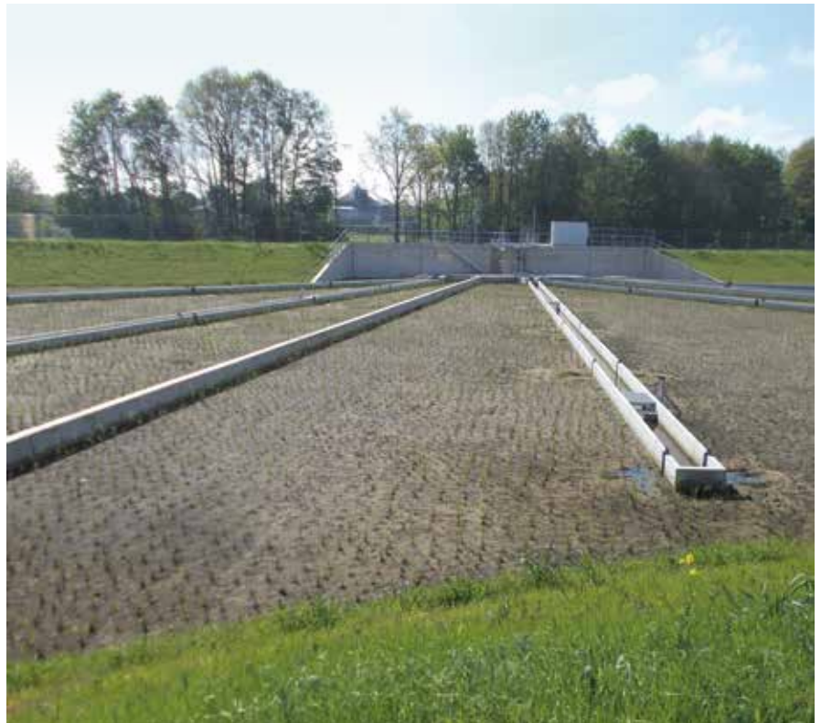
Retentionsbodenfilter Rheinbach nach dem Einpflanzen des Schilfs
