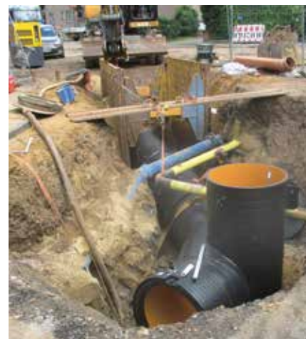
Offene Kanalverlegung
