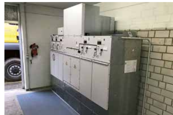
Erneuerte Mittelspannungsanlage
