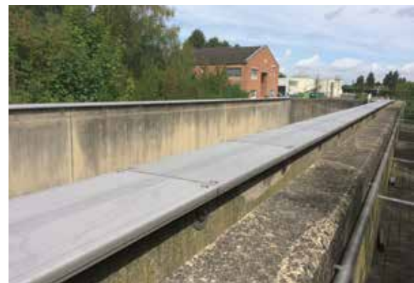
Räumerlaufbahnen aus Edelstahl
