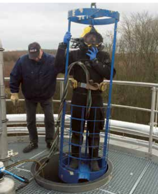
Taucher beim Ablassen in den Faulbehälter
