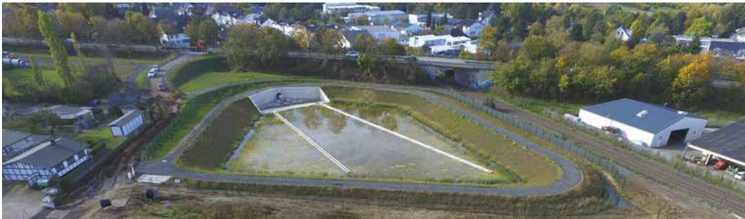
Retentionsbodenfilter Bonner Straße – Meckenheim
