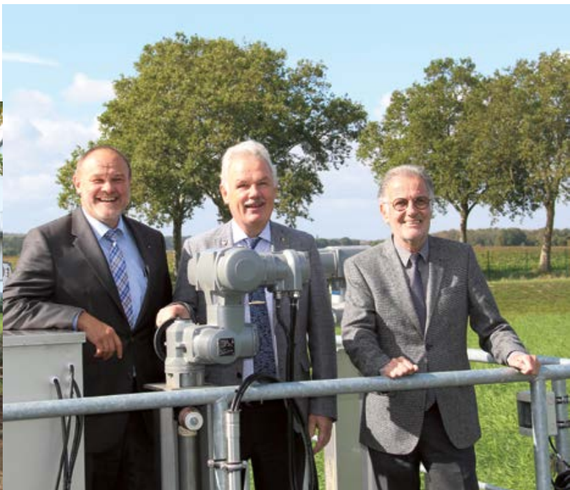
Inbetriebnahme des Retentionsbodenfilters Rheinbach
