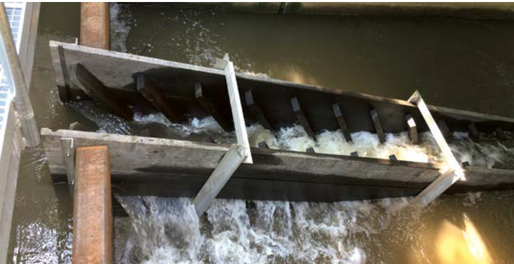
In die neue Stahltafel eingegangener Denil-Fischpass
