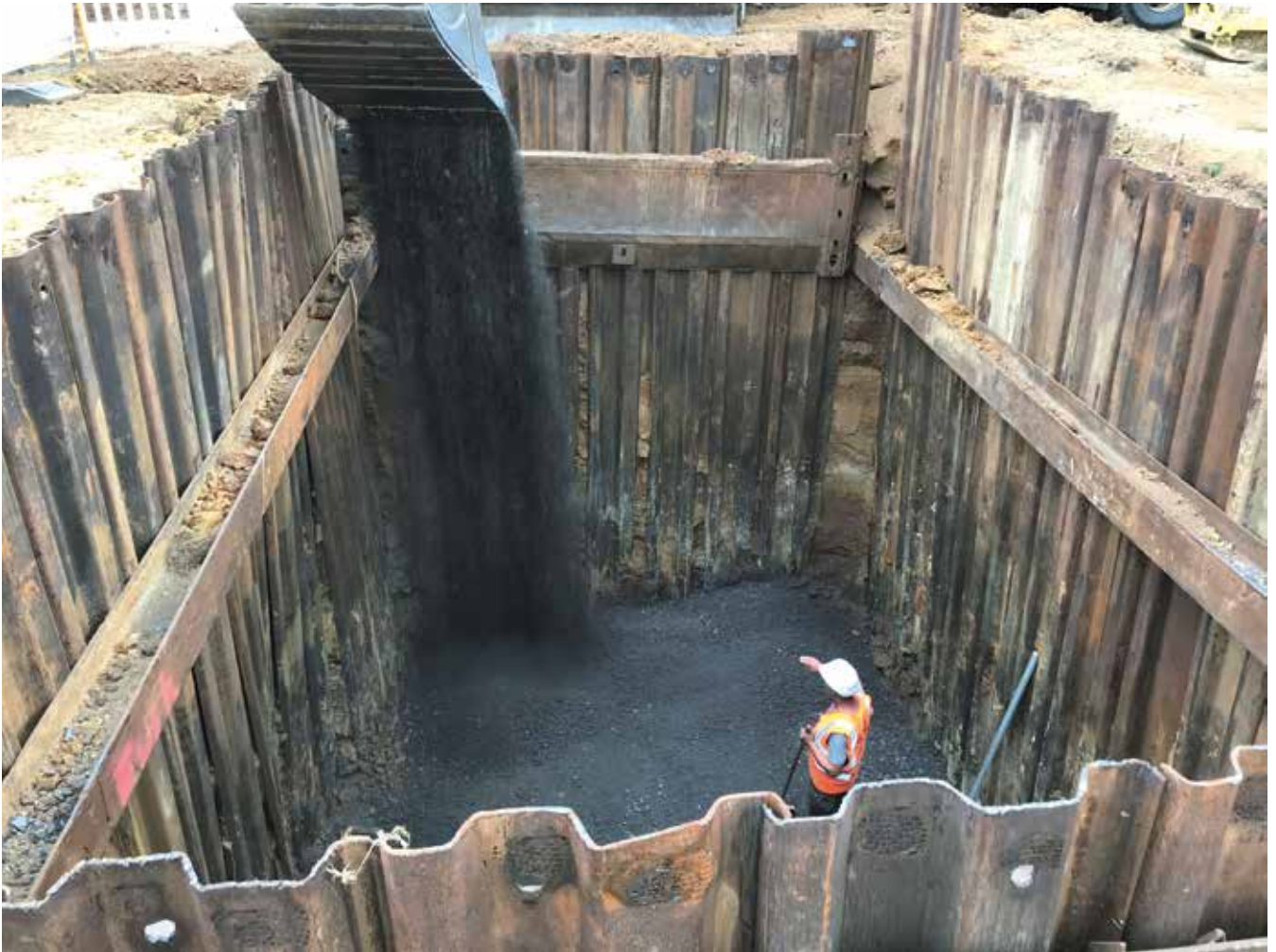
Regenüberlaufbecken Keltenring im Bau
