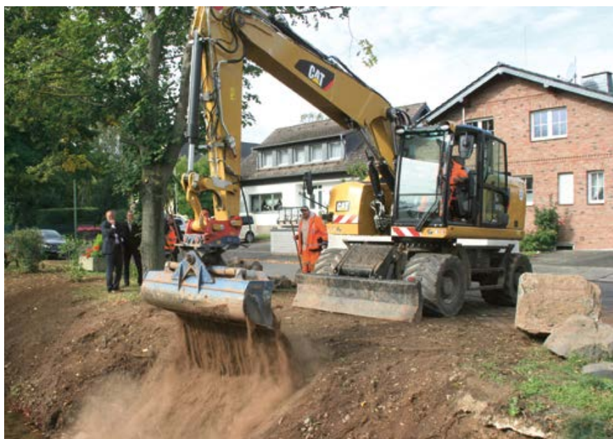
Aufweitung des Rotbachprofils in Züllich-Schwerfen
