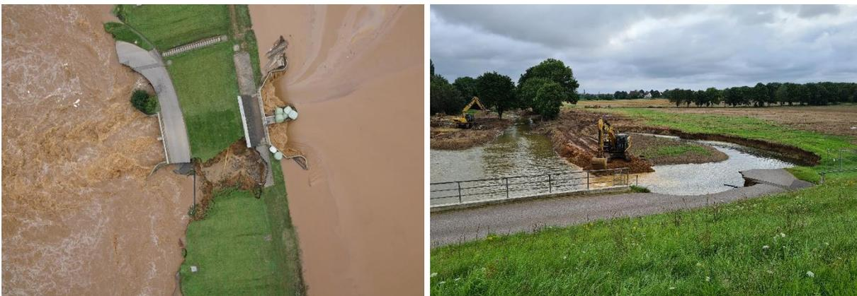
**Abb. 15:** links: Luftbildaufnahme des Damms mit dem Sperr- und Ablaufbauwerks am 15.7. um 10:45, rechts: provisorische Wiederherstellung der Erftböschung unterhalb des Damms.
