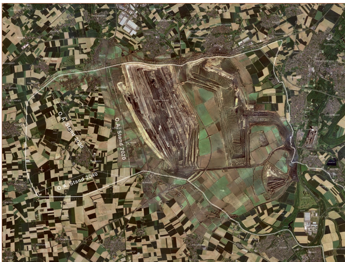
Abbildung 31 Autobahndamm A 44n (Stand Anfang 2018)
