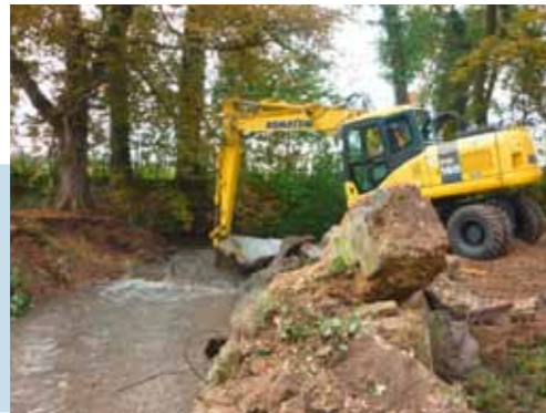
Beseitigung eines Wehrs am Neffelbach, damit Fische und andere Lebewesen wandern können.
