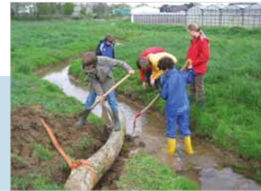
Einbringen von Totholz
