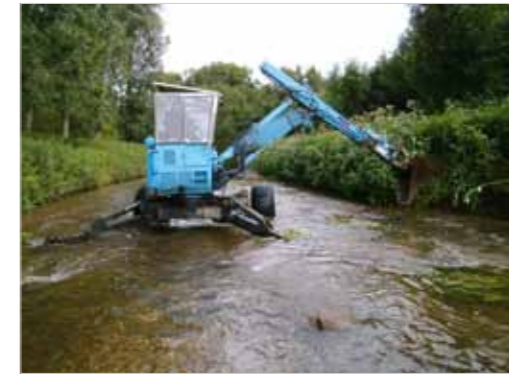
Entfernen der Uferbefestigung
