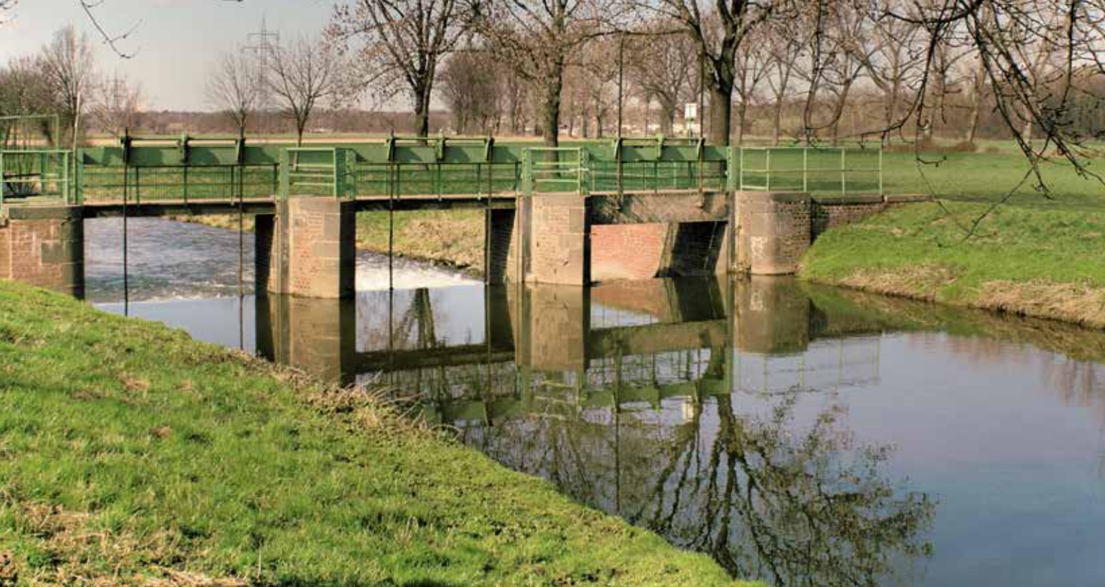
Wehr »W1« bei Kerpen-Türnich
