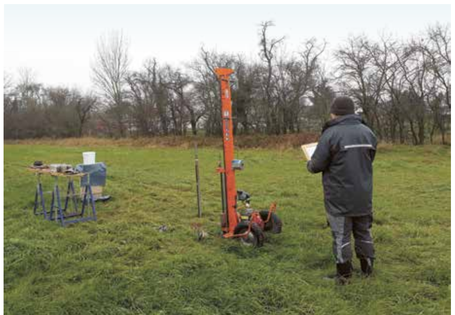
Baugrunduntersuchungen am Rotbach in Sinzenich
