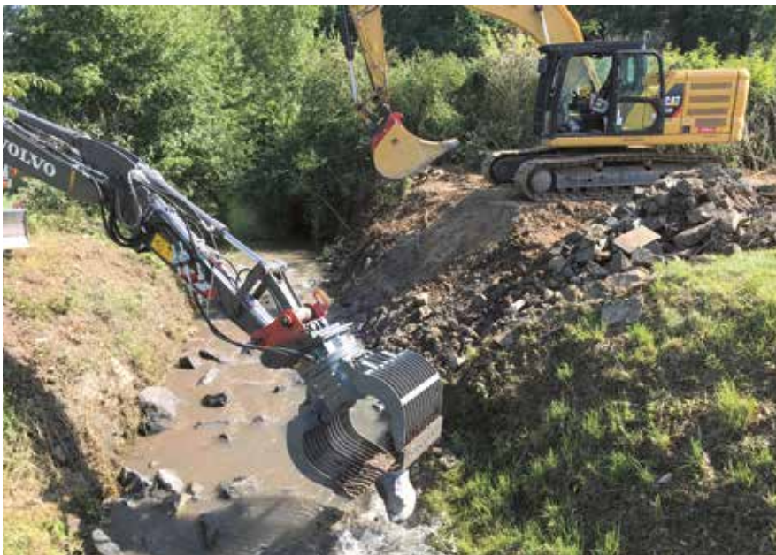
Bagger beim Aufbau der Sohlengleite bei Hochkirchen
