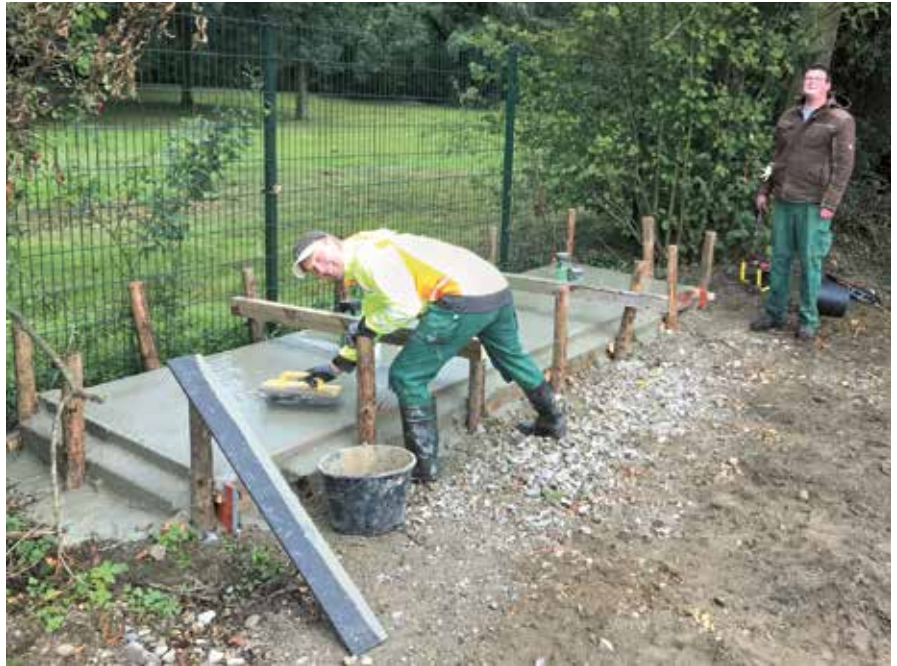
Mitarbeiter der GM Münchrath bei Betonierarbeiten für die neuen Steuerschranke der Wehranlage W8
