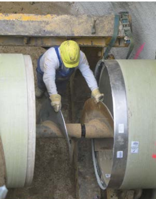
Meckenheim – Kreuzung der Bahntrasse mittels Schneckenbohrverfahren
