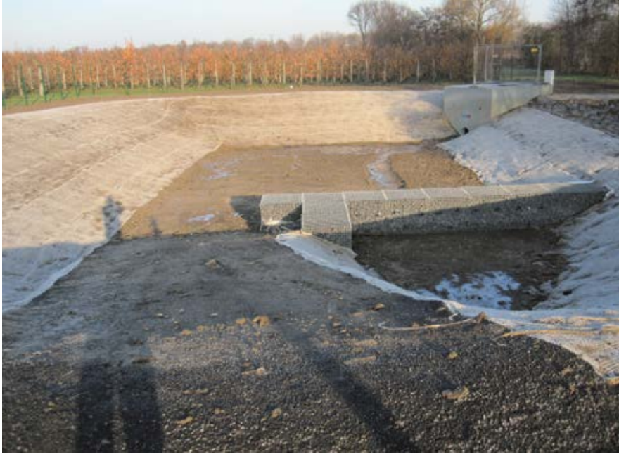
Meckenheim – Regenrückhaltebecken Ersdorf
