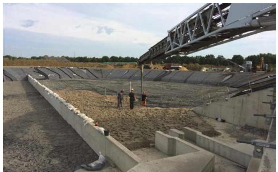
Retentionsbodenfilter Rheinbach – Einbau des Aktivkohle-Sandgemisches mittels Telebelt
