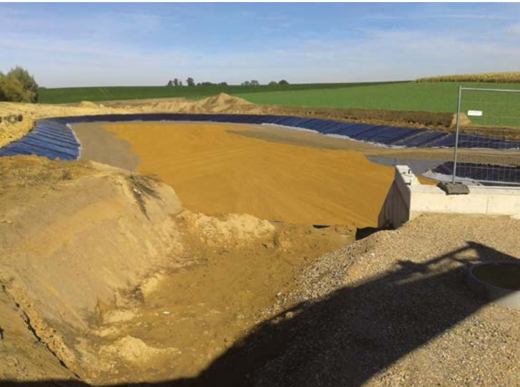
Rommerskirchen – Regenrückhaltebecken Sinsteden
