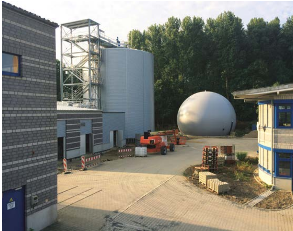
GKW Kaarst-Nordkanal – Gasbehälter, Faulturm und Maschinengebäude
