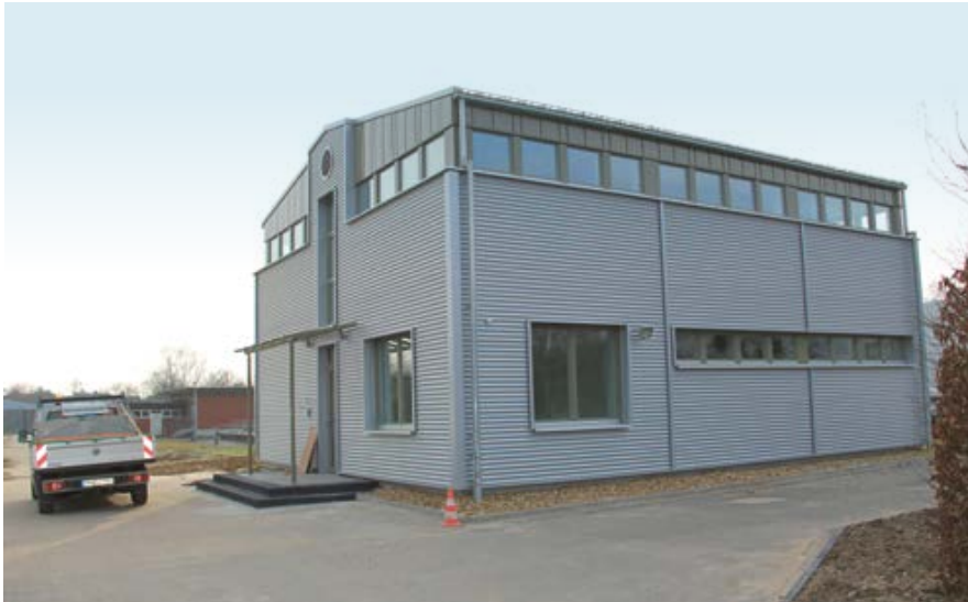
Neubau der Gewässermeisterei Bergheim
