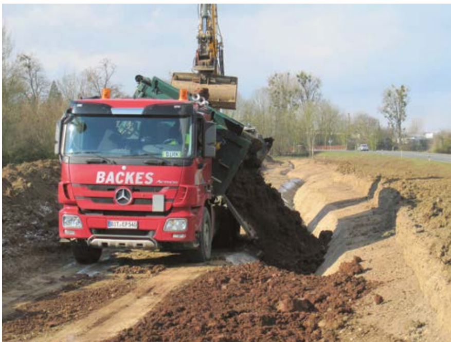
Einbau der innenliegenden Lehmichtung in die rückverlegte Verwallung
