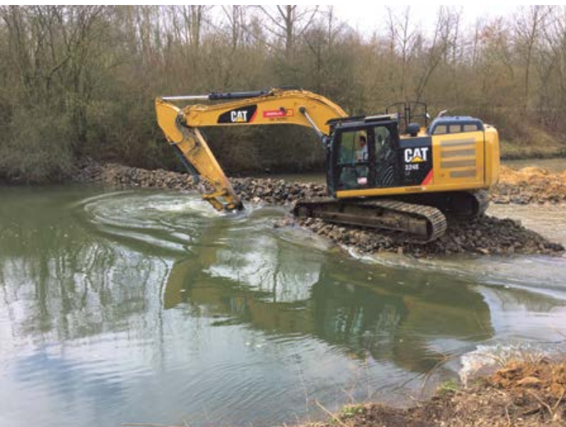
Bagger beim Bau einer Buhne zur Strömungslenkung
