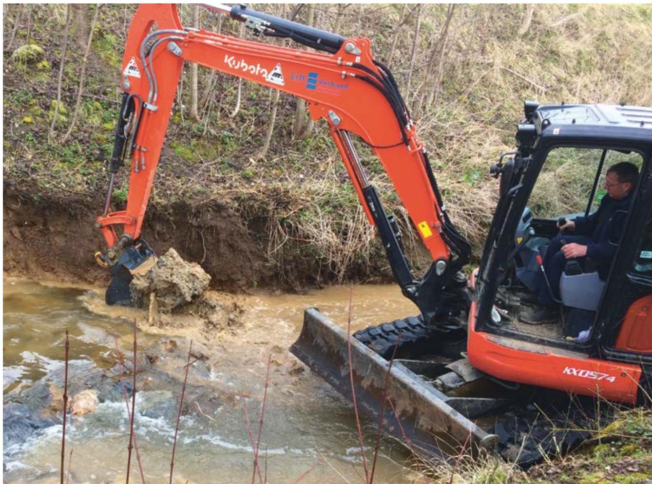
Ausbau der Böschungssicherung des Neffelbachs mit dem Minibagger
