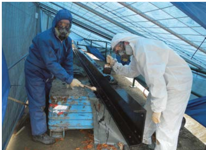
Schutzlackierung eines Stahlträgers vor Ort
