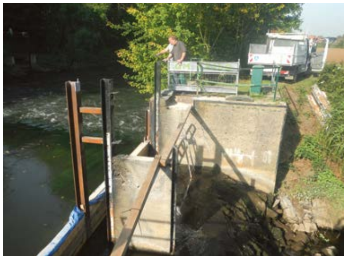
Das Schütztafelwehr 6.1 während der Sanierungsarbeiten
