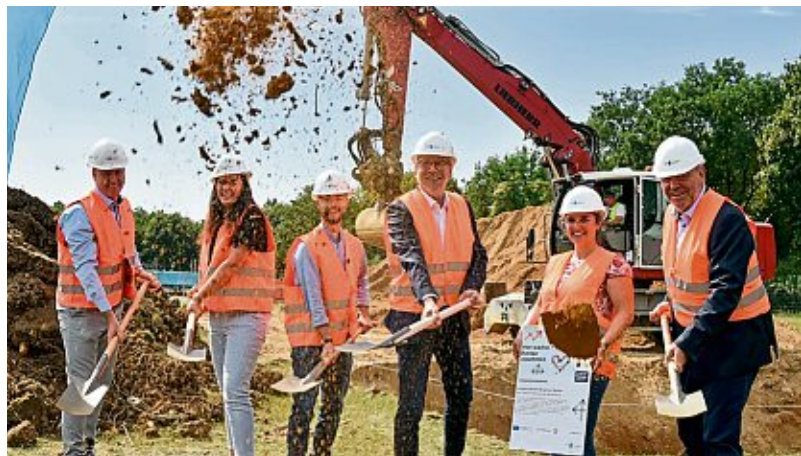
Beim ersten Spatenstich: Bereichsleiter für Abwassertechnik René Düppen, Planungsingenieurin Svetlana Lakicevic, Betriebsingenieur Klaus Jochen Buir, Bürgermeister Volker Mießeler, Bauleiterin Anne Kreder und Vorstand Heinrich Schäfer.
