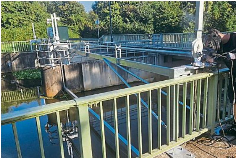
Der Erftverband hat nun auch am Wehr in Bedburg-Broich einen Rettungsbalken anbringen lassen. Er soll verhindern, dass Menschen in den lebensgefährlichen Sog des Wehrrs geraten.
